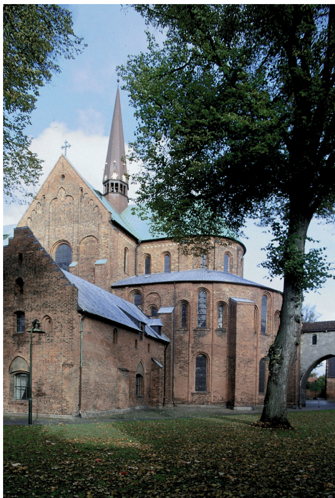
Katedralen i Roskilde ble bygget i det 12. og 13. århundre og er Nordens første gotiske katedral i murstein. (Foto: Kulturarvsstyrelsen)
