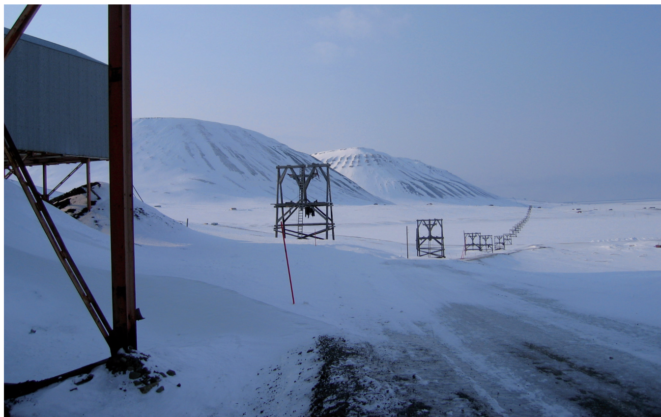
Taubanene utenfor Longyearbyen på Svalbard fraktet kull fra gruvene i fjellene omkring byen og inn til taubanesentralen. (Foto: Susan Barr, Riksantikvaren)
