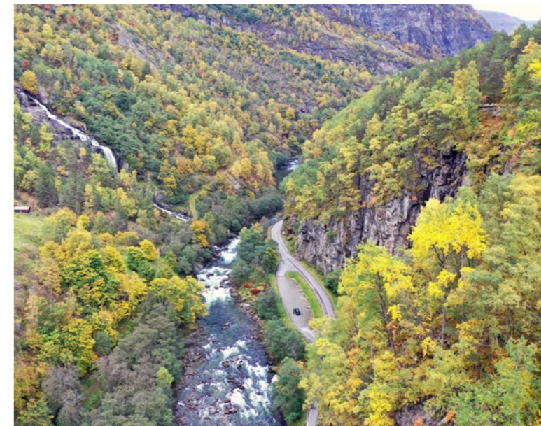
Gjennom dette tronge partiet av dalen ved Galdane går det fleire vegtrasear. Foto/dronebilete: Glenn Heine Orkelbog, Vestland fylkeskommune
