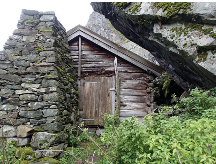
Husmannsplassen Almen, der stovehuset er bygd delvis under ein kampestein slik at det er verna mot ras. Foto: Åse Bitustøl, Riksantikvaren
