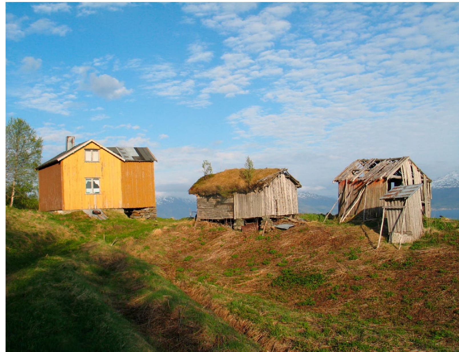
Bygningsmiljø Brenna. Foto: Arne Håkon Thomassen, Sametinget
