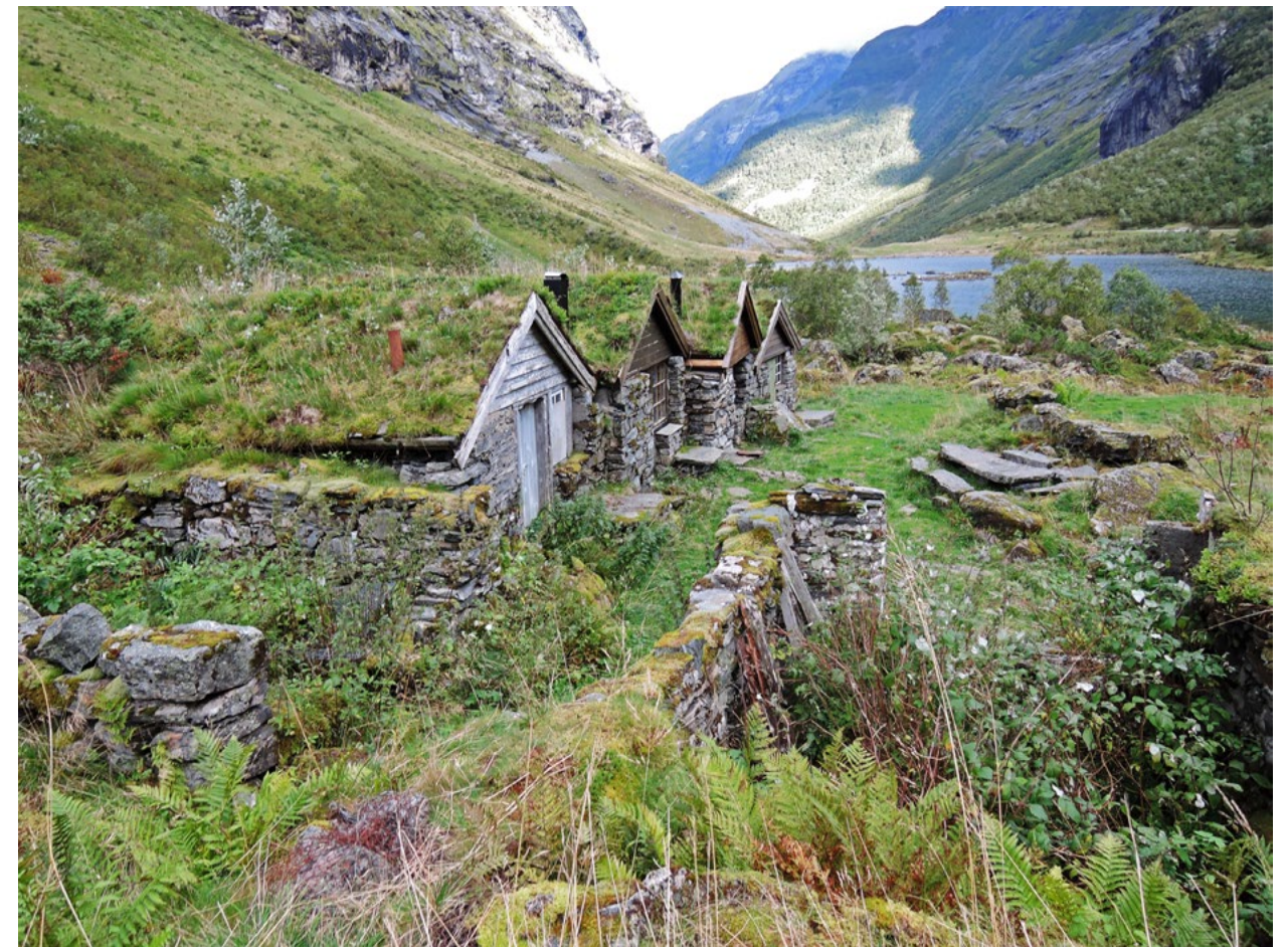
Urasetra, Norangsdalen. Fem steinbuer, delvis gravd ned i bakken, i ly av større blokksteinar. Foto: Oskar Puschmann.
