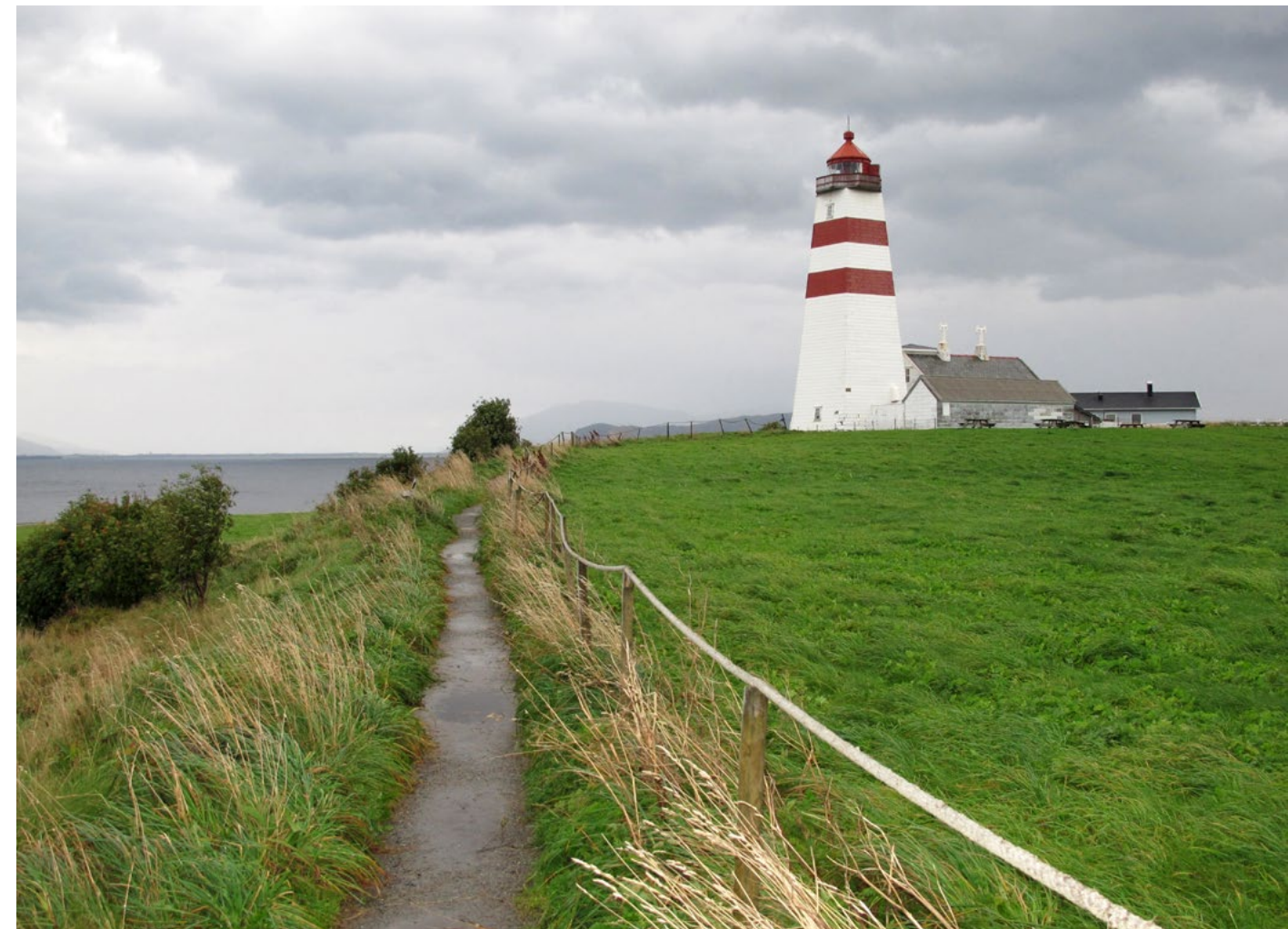
Alnes fyrstasjon, Alnes. Foto: Anders Amlø, Riksantikvaren.
