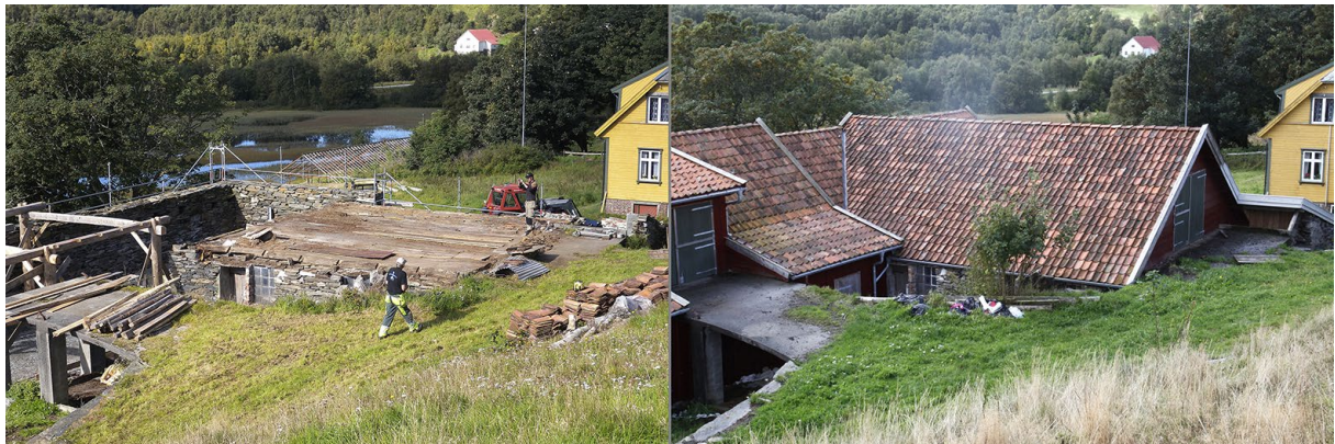
Bilde 12. 2010 – 2014. Istandsetting av løe med fjøs og stall – i starten av arbeidet og det ferdige resultatet. Fra Førsvoll i Rennesøy UKL, Stavanger kommune.
