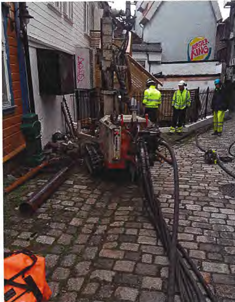
a) Borerigg og sensor installasjon
