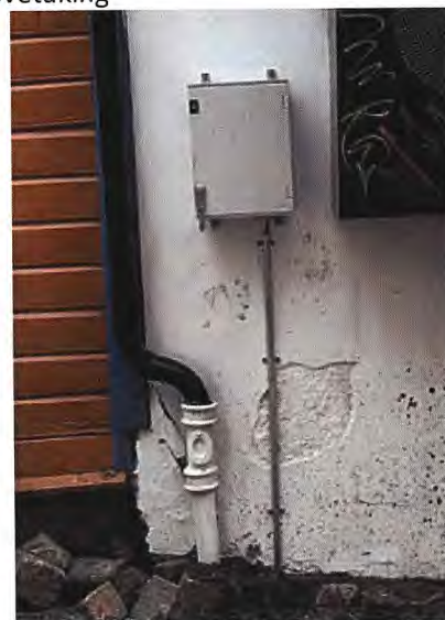
d) Ferdig montert installasjon
