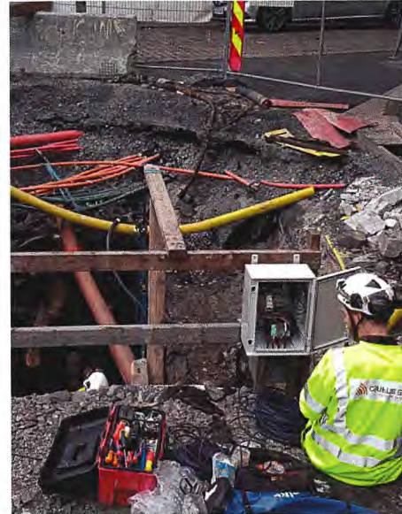
e) Installasjon midlertidig strømforsyning
