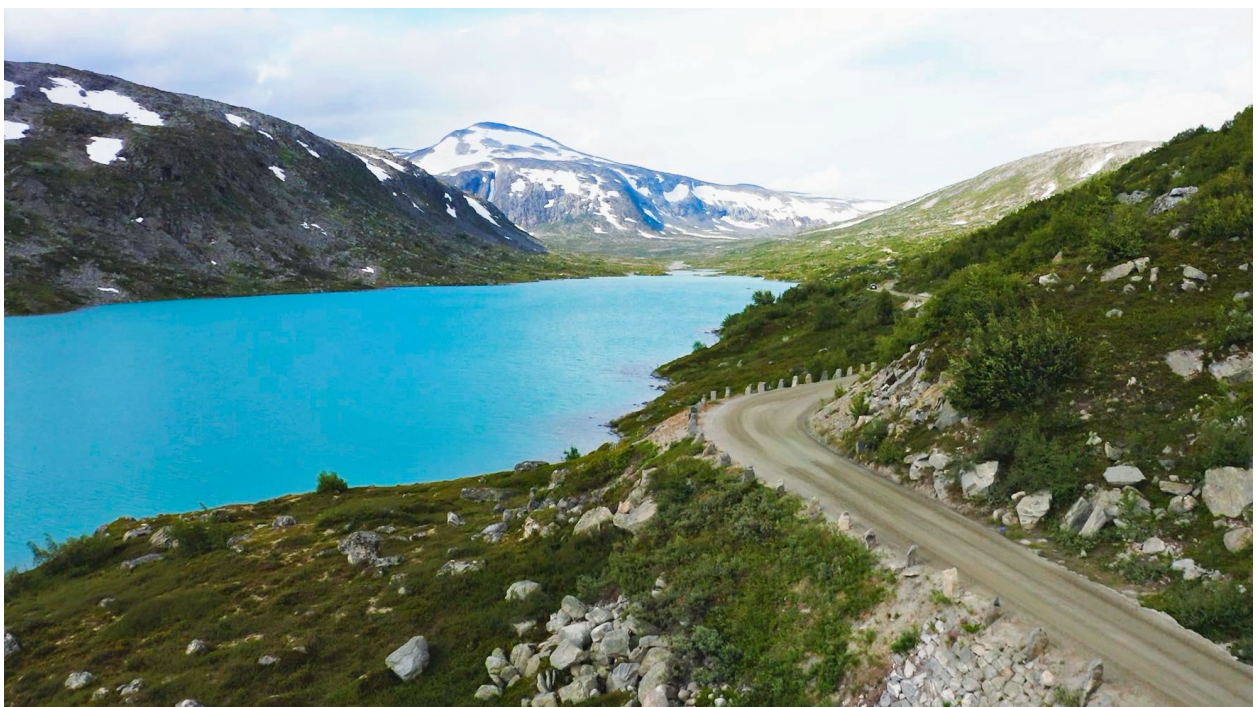
1800-talsvegen over Strynefjellet er nyleg restaurert slik at dei fine, handlaga murane og stabbesteinane langs kanten har kome til sin rett att. Her med Heillstuguvatnet i bakgrunnen. Foto: Andreas Nilsson
