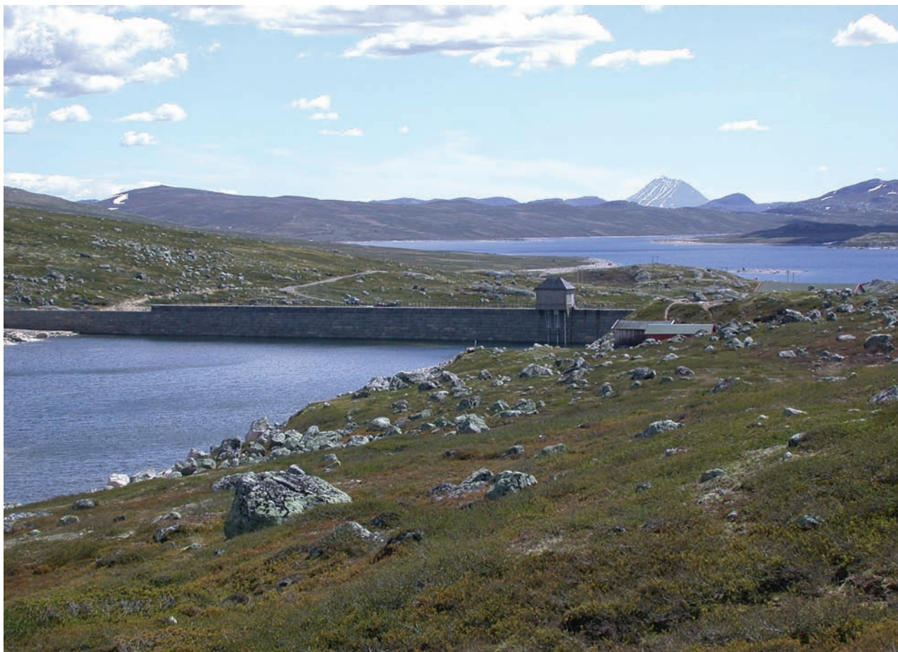
Mårdammen med utsikt mot Kalhovdfjorden, Tinn kommune., Telemark. Gaustatoppen i bakgrunnen. Reguleringsområdet i Mår omfatter i dag magasinene Mårvatn, Kalhovd, Gøyst, Strengen og Grotte. Magasinene i Mår og Kalhovdfjorden ble etablert etter konsesjoner gitt i 1913 og 1915, og reguleringene ble utnyttet i kraftverkene nedenfor Tinnsjøen. Konsesjonene ble gitt for 70 år og ble fornyet i 1998. I forbindelse med bygging av Mår kraftverk ble det gitt konsesjoner i 1943 (stadfestet 1948) og til ytterligere reguleringer og overføringer i 1956. Konsesjonstiden for disse er tidsbegrenset med mulighet for revisjon av vilkårene fra 2006. Det ble ikke foretatt systematiske arkeologiske undersøkelser før disse reguleringene. Mindre undersøkelser og befaringer senere viser at området er usedvanlig rikt på kulturminner, også innenfor reguleringsmagasinene. Foto: Gaute Reitan, Kulturhistorisk museum, Universitetet i Oslo.
