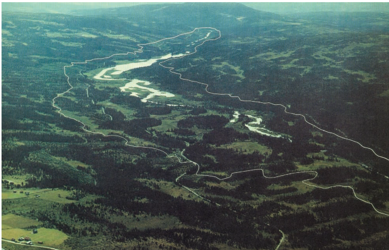
Dokkfløy for utbygging, med høyeste regulerte vannstandsniå tegnet inn. Utløpet med damstedet ligger ved enden av vannet, lengst borte. Foto: Fjellanger Widerøe A/S.
