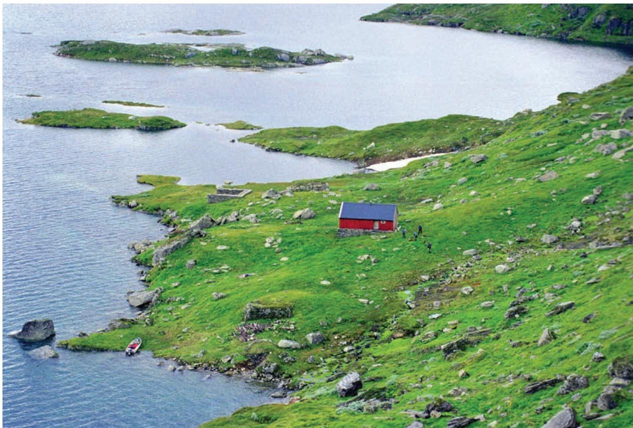
Bjølsegrøvatn, Kvam kommune, Hordaland er blitt regulert flere ganger i forbindelse med utbyggingen av Bjølvo kraftverk, første gang i 1918 med en oppdemming på 16 meter til ca. 890 moh. I 2000 ble det, i forbindelse med søknad om fornyet konsesjon, for første gang foretatt kulturminneregistrering i området. Flere automatisk fredete kulturminner ble påvist og dokumentert, bl.a. en hustuft med lave veggvoller. Trekull fra et prøvestikk i tufta (hvor personene står) er datert til kelletid. Bjølsegrø er gammel støl. Ved reguleringen i 1918 måtte bygningene flyttes høyere opp i terrenget. Ruiner av de eldre stølsbygningene er fremdeles synlige fra båt ved lav vannstand. Bildet er tatt i august 2000 ved fullt magasin. Foto: Kjell Arne Valvik, Hordaland fylkeskommune.
