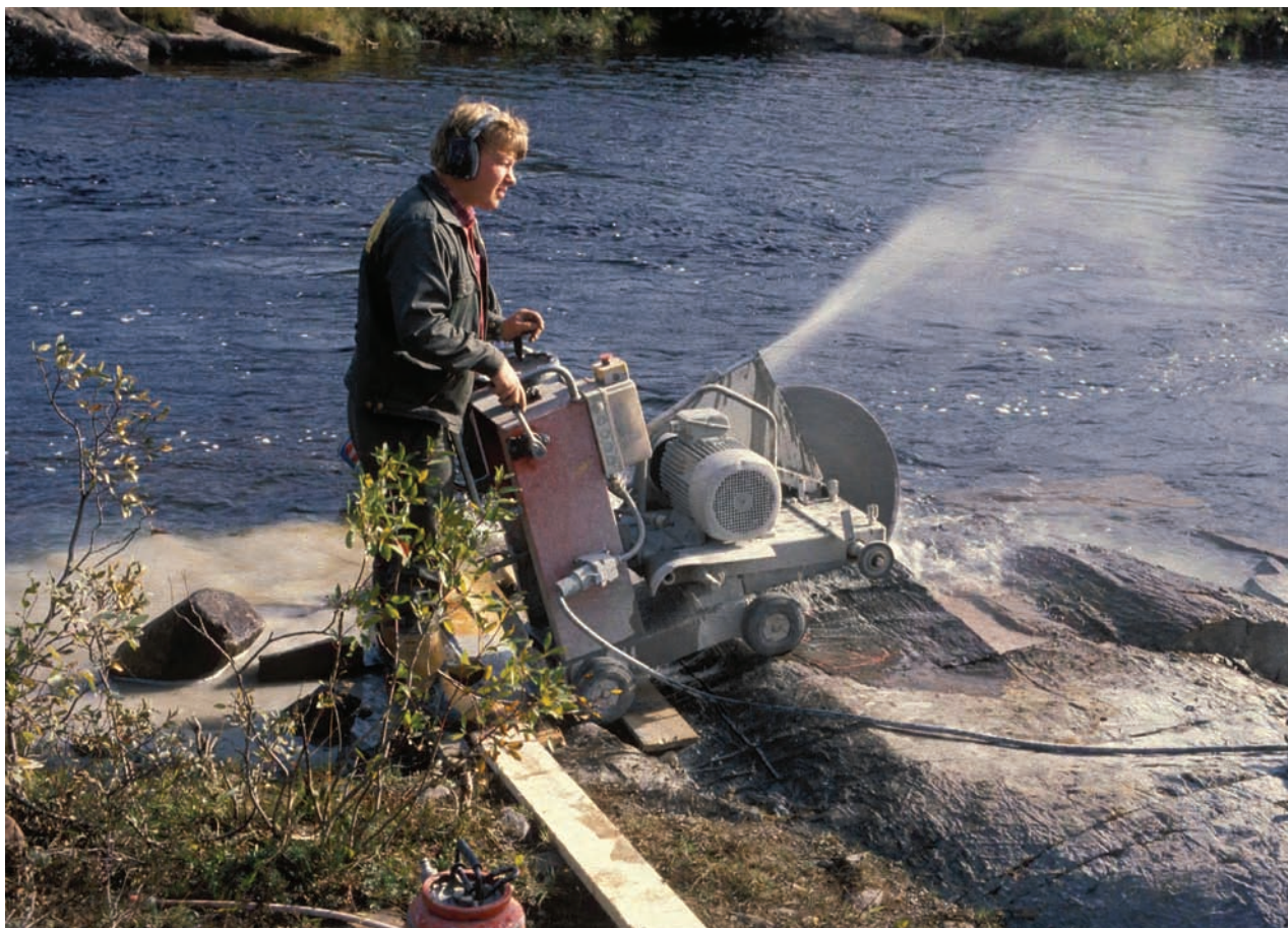
En spesiell, og forholdsvis lite brukt form for sikringstiltak, er å flytte kulturminnet bort fra fareområdet. Helleristningene ved Dokkfløy, som stod i fare for å bli neddemt, ble reddet på denne måten. Et stykke av berget, med ristningene på, ble saget løs og flyttet til Kittilsbu, hvor det nå er plassert ved Utmarksmuseet. Foto: Jan Henning Larsen, Kulturhistorisk museum, Universitetet i Oslo
