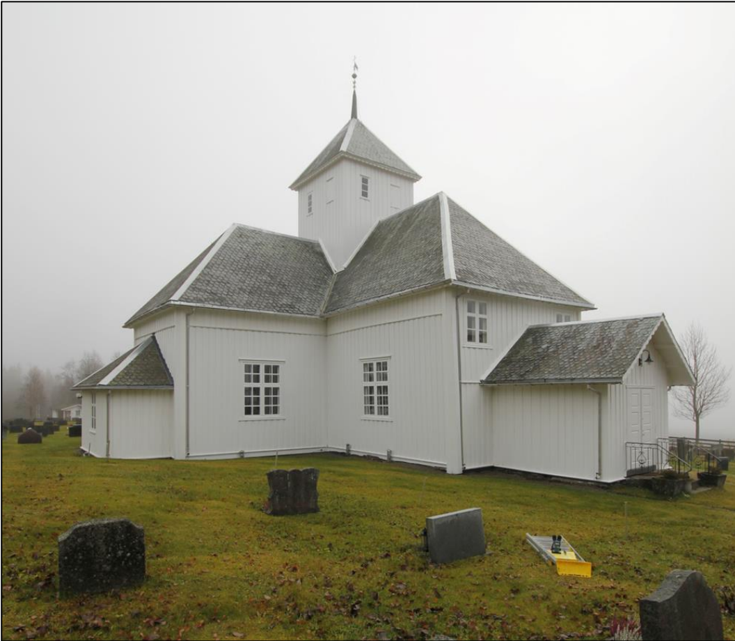
Figur 5. Lunde kirke. Sett fra nordvest. Nytt våpenhus og i tilbygg mot nord. Foto: J. Brønne 27.10.2022.
