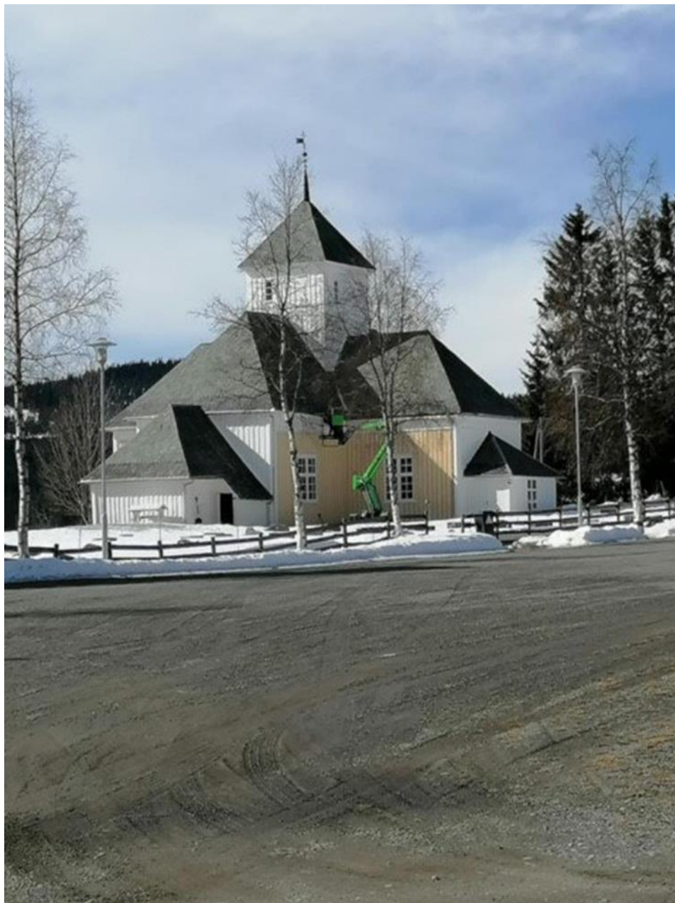
Figur 18. Lunde kirke. Alt panel er skiftet mot nordøst. Udatert bilde tatt av de som utførte arbeidet, vedlagt i «rapporteringen» av de utførte arbeidene på kirka.
