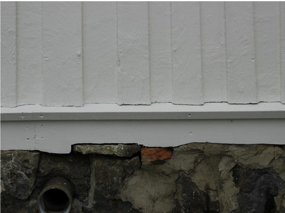
Figur 9. Lunde kirke. Detalj av opprinnelig panel på sørveggen. Sokkellista og dekkbordet som er pent krabbet rundt grunnmuren er nye. Foto: J. Brønne 27.10.2022.
