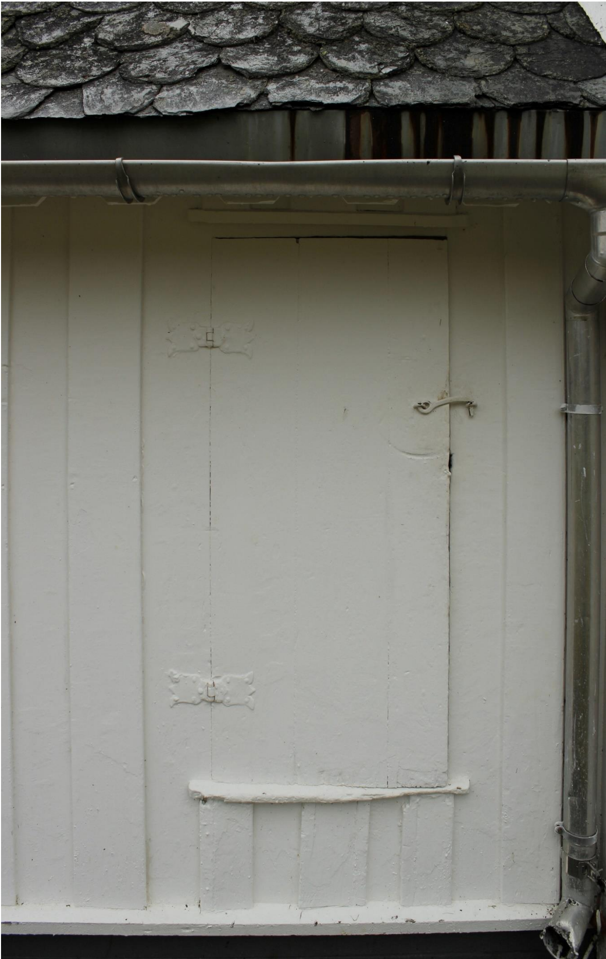
Figur 14. Lunde kirke. Døra i tilbygget mot nord. Døra leder inn til et lite lagerrom. Legg merke til de vakre smidde «tulipanhengslene». Hengslene kan være ca. 100 år eldre enn panelet og dørene. Tilsvarende hengsler er det på døra i figur 11. Foto: J. Brønne 27.10.2022.
