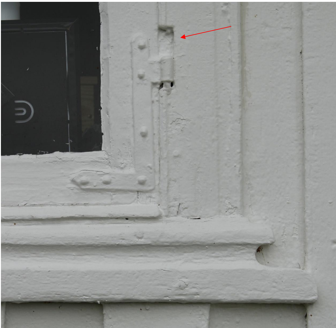
Figur 21. Lunde kirke. Detalj av opprinnelig vindusgerikt, med spor tatt ut i gerikten, slik at vindusrammen kan løftes av. (Rød pil). Foto: J. Brønne 27.10.2022.
