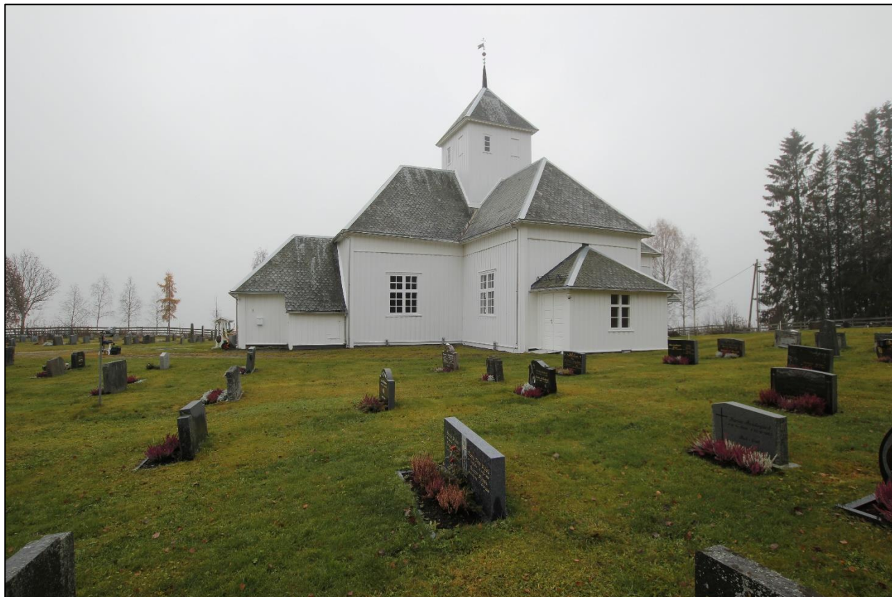
Figur 7. Lunde kirke. Sett fra nordøst. Nytt våpenhus i tilbygg not nord. Foto: J. Brønne 27.10.2022.
