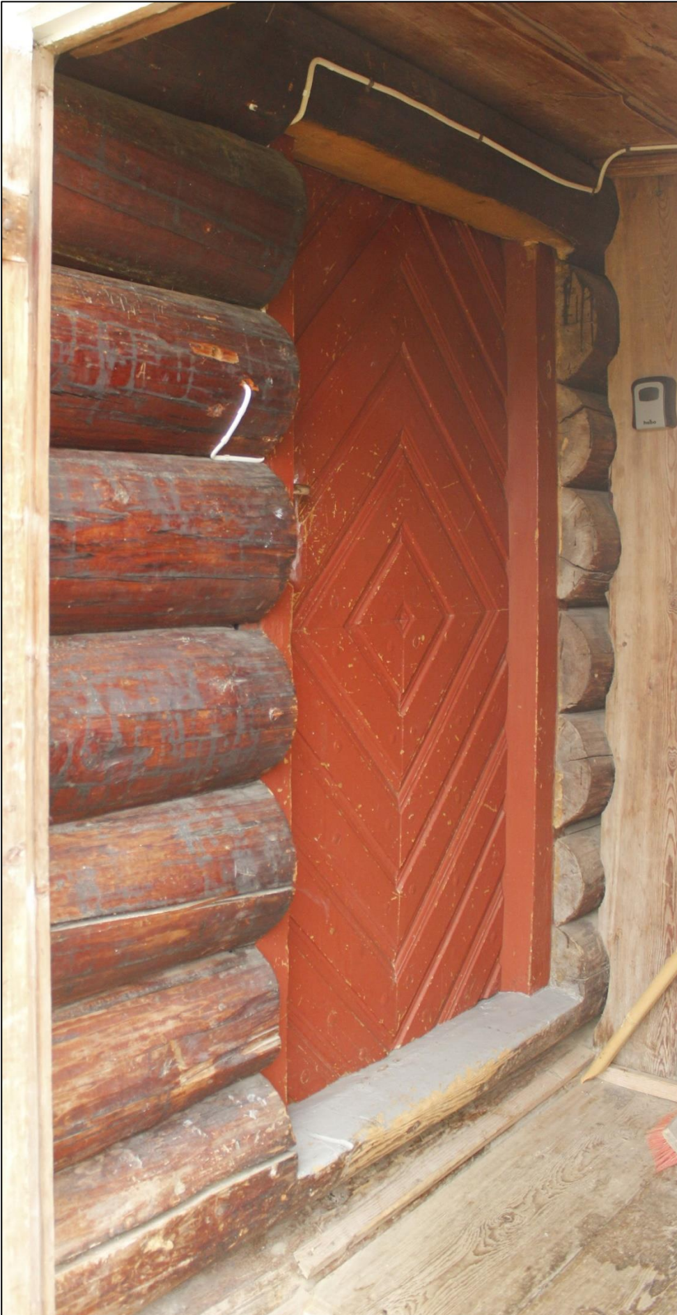
Figur 13. Lunde kirke. Sakristidøra. Døra er trolig opprinnelig i kirka, men kan være flyttet fra nordre korsarm eller et døra har stått som hoveddør mot vest. Forhuggingen i stokken over døra, og mangelen av overkarm tyder på at den er flyttet til stedet den nå står. Foto: J. Brønne 27.10.2022.
