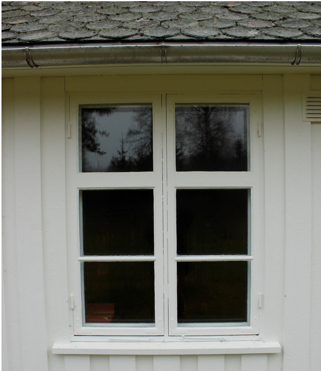
Figur 17. Lunde kirke. «Krysspostvindu» i nordre korsarm. Kopi av de eldre, tilsvarende vinduene i kirka. Foto: J. Brønne 27.10.2022.
