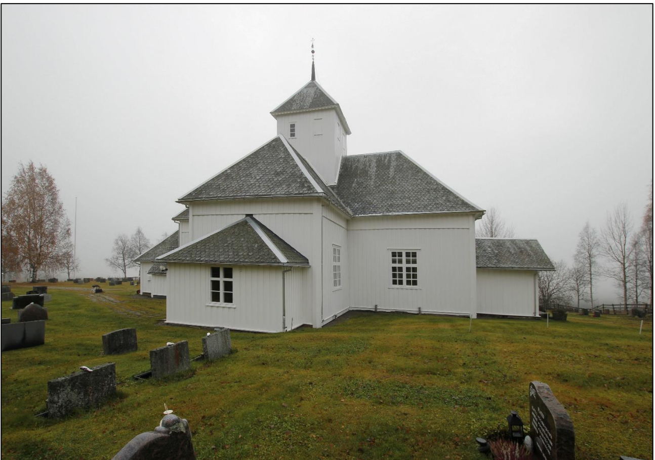
Figur 6. Lunde kirke. Sett fra nordvest. Nytt våpenhus i tilbygg mot nord. Foto: J. Brønne 27.10.2022.
