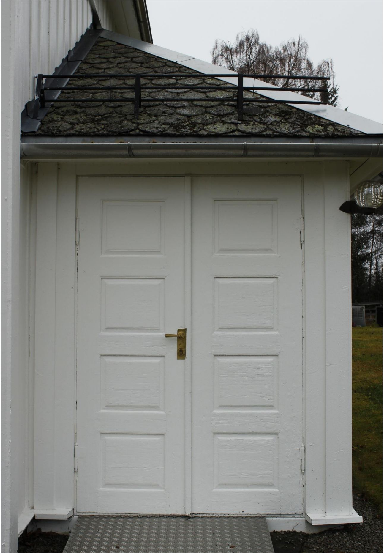
Figur 11. Lunde kirke. Østdøra i nordre korsarm. Tilbygget med ny inngang er tydeligvis utført for å få akseptabel tilgang for alle brukere av kirka. Foto: J. Brønne 27.10.2022.
