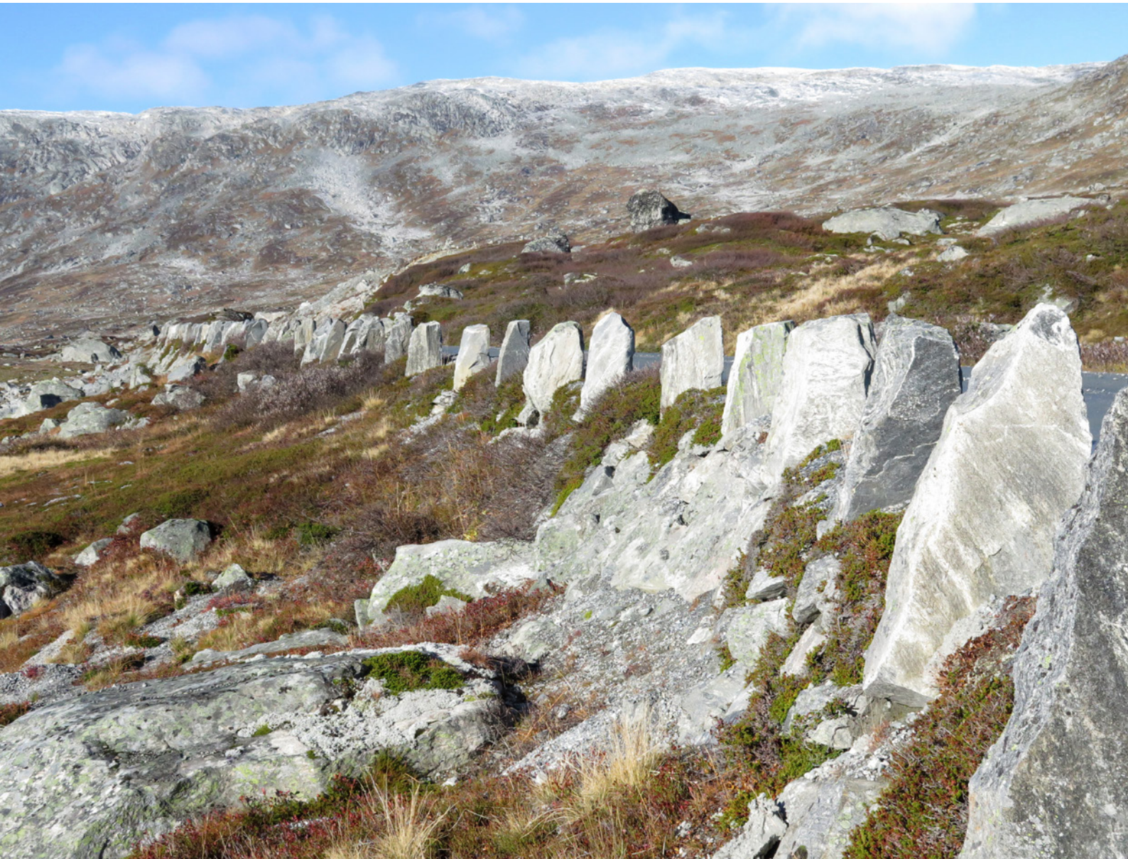
Gamle Strynefjellsveg vart bygd som turistveg på slutten av 1800-talet og viser godt byggjemåten frå den tida. Foto: Siri Hagen, Riksantikvaren
