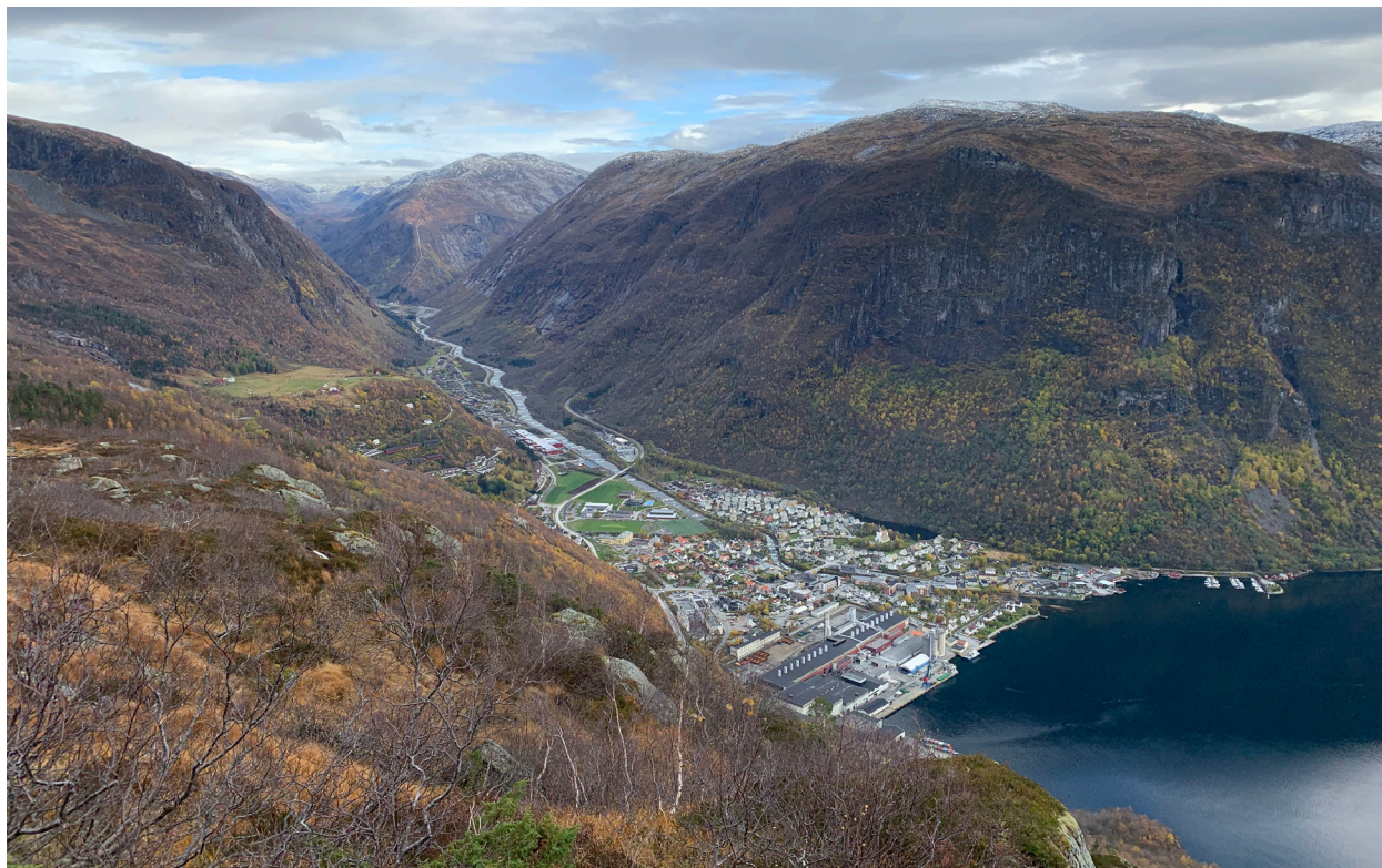
Delar av området sett frå Grimsoen. Tettstaden Høyanger med fabrikkannlegga nede ved fjorden. Lenger innover dalen er Daleelva, og lengst bak i bildet ser vi rørgata og trallebana til Kraftstasjon 2. Foto: Arlen Bidne, Vestland fylkeskommune
