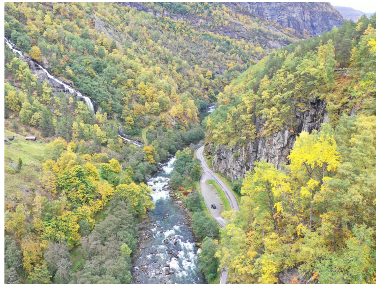
Gjennom dette tronge partiet av dalen ved Galdane går det fleire vegtrasear. Foto/dronebilete: Glenn Heine Orkelbog, Vestland fylkeskommune
