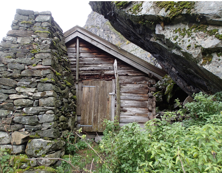
Husmannsplassen Almen, der stovehuset er bygd delvis under ein kampestein slik at det er verna mot ras. Foto: Åse Bitustøl, Riksantikvaren
