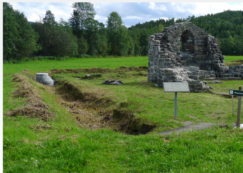
Som en del av dreneringsplanen, ble en kum satt ned på utsiden av kirkegårdsmuren. Den ble i første omgang svært dominerende ved siden av ruinen. Aug. 2012
