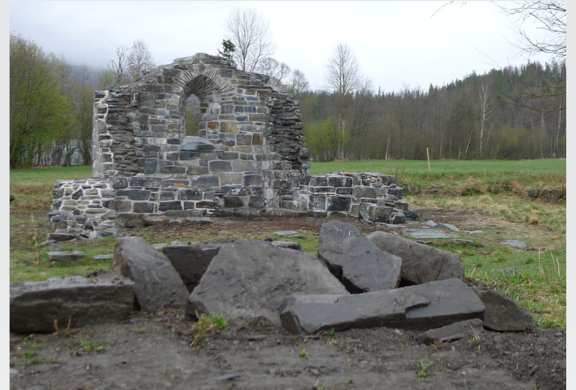
Ved prøvegraving sør-vest for ruinen sommeren 2012, ble det avdekket steiner som stammet fra ruinen. RA måtte stoppe arbeidet med planlagt terrengforming.
