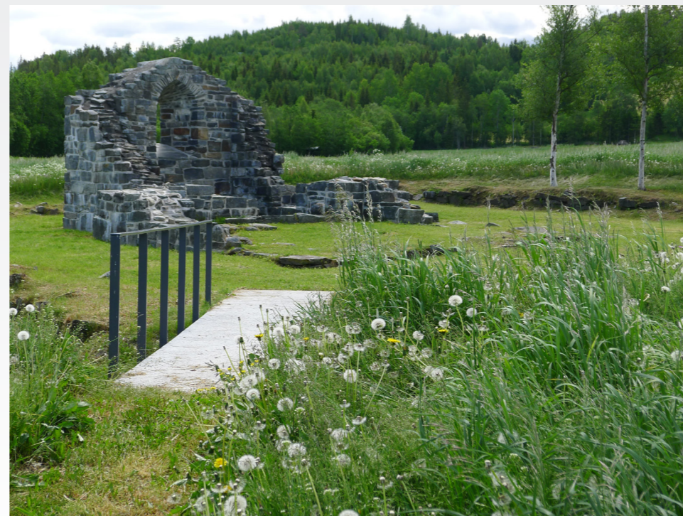
Ny rampe i betong med handløper på den ene siden. Skiltene er fjernet fra muren. Juni 2015.
