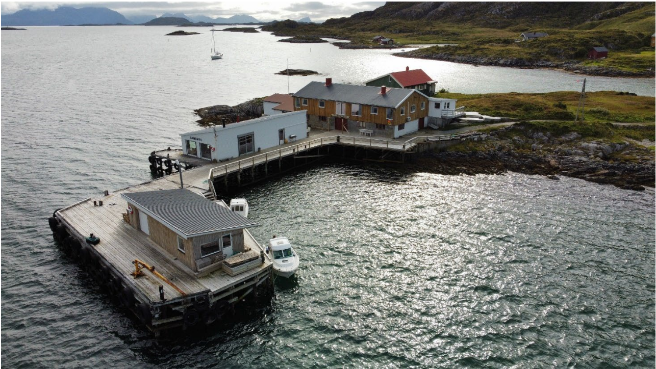
Figur 8: Kaianlegget på Sandøya er tilknyttet det tidligere fiskebruket, og utgjør et helhetlig og spesielt godt bevart havnemiljø fra tidlig etterkrigstid. Anlegget består av drifts- og lagerbygninger med tilhørende kai for avlevering av fisk, og med utstikker for anløp av lokalbåt. Alle elementene er godt bevart, foruten fiskehjellene som er fjernet. Kulturmiljøet er ett av mange kulturmiljøer prioritert i forslag til Tromsø kommunes «Kommunedelplan for kulturmiljø fra 2021». Et utvalg bygninger fra dette er lagt til i 5. omdrev. Foto: RM/ASPLAN VIAK 2021.
