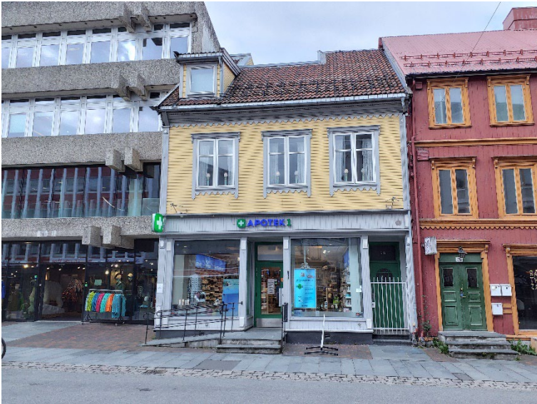
Figur 20: Eksempel på liten endring (C). Utskifting av takteking og mindre fasadeendringer. Foto: SRJ/ASPLAN VIAK 2021 (19020114014).
