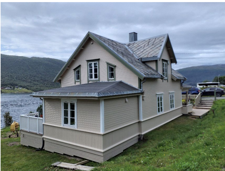
Figur 21: Eksempel på middels endring (B). Etter at dette våningshuset ble SEFRAK-registrert i 1992 har det fått et mindre tilbygg som underordner seg helheten. Foto: IB/ASPLAN VIAK 2021 (19023103040).
