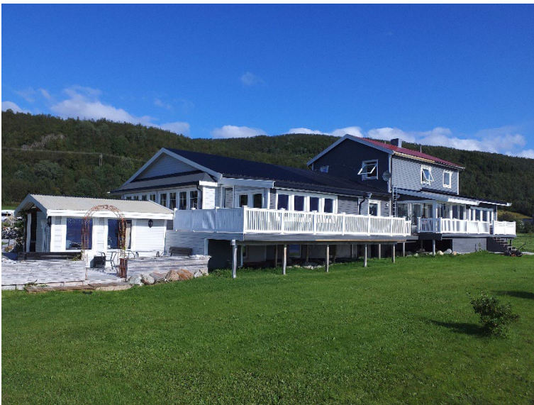
Figur 22: Eksempel på stor endring (A). Bygningen er utvidet med flere større tilbygg. Foto: AR/ASPLAN VIAK 2021 (19024001042).
