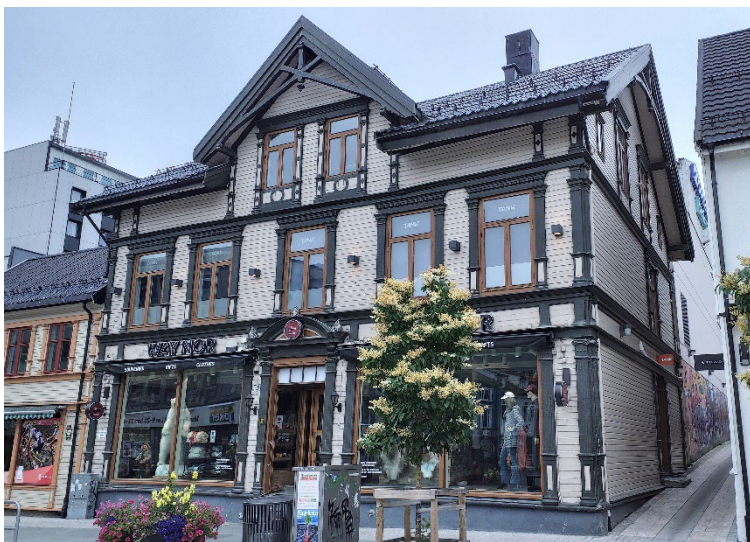
Figur 45: Denne bygården i Storgata er regulert med hensynssone bevaring kulturmiljø i «Kommunedelplan for Tromsø sentrum 2007-2018». Eier har byttet ut opprinnelig skifertak med nytt metallplatetak (liten endring C). Foto: HT/ASPLAN VIAK 2021 (19020116013).
