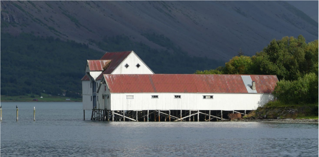
Figur 9: Sjøhus og brygge tilknyttet Jøvik handelssted er SEFRAK-registrert. Kulturmiljøet er det best bevarte og mest komplette og autentiske av sitt slag innenfor dagens kommunegrenser. Foto: HT/ASPLAN VIAK 2021 (19023301001).
