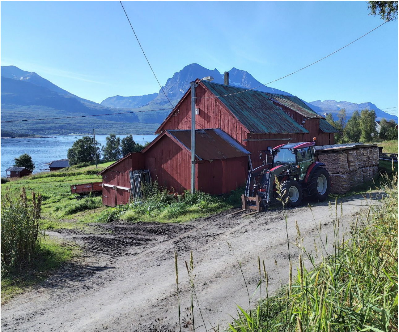
Figur 48: Driftsbygninger i tunet sammen med mindre uthus i/nær tunet har høyest akkumulert tapsandel av alle undersøkte bygningstyper i Tromsø. 45 % av begge disse bygningskategoriene er tapt siden den opprinnelige SEFRAK-registreringen. Gjennomsnittlig tapsandel for alle bygningstyper i Tromsø er 29 %. Driftsbygningene utgjør 7 % av de gjenstående bygningene eldre enn 1900 i kommunen. Foto: HT/ASPLAN VIAK 2021 (19024004021).
