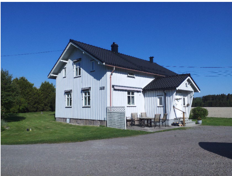
Figur 21: Eksempel på middels endring (B). Etter at dette våningshuset ble SEFRAK-registrert i 1973 har det fått et mindre tilbygg som underordner seg helheten. Foto: HT/ASPLAN VIAK 2021 (2330013005).
