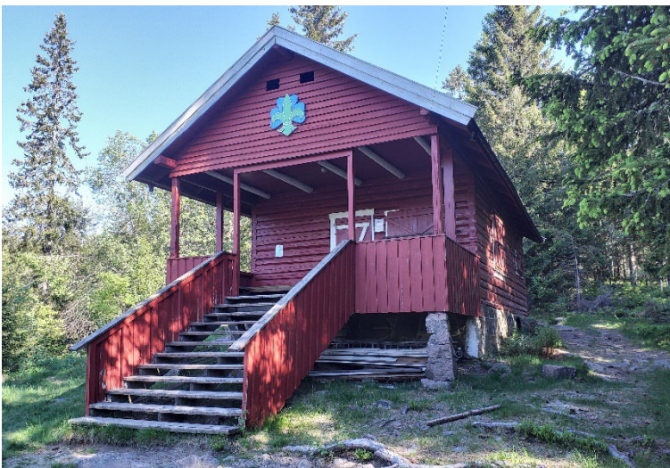
Figur 48: Speiderhytta «Fredlyst» ved Kjulstjern er et eksempel på en bygning som kommunen vurderer å ta med i rulleringen av kulturminneplanen. Bygningen er ikke tidligere SEFRAK-registrert, og omfattes ikke av noe formelt vern i dag. Foto: HT/ASPLAN VIAK 2021.
