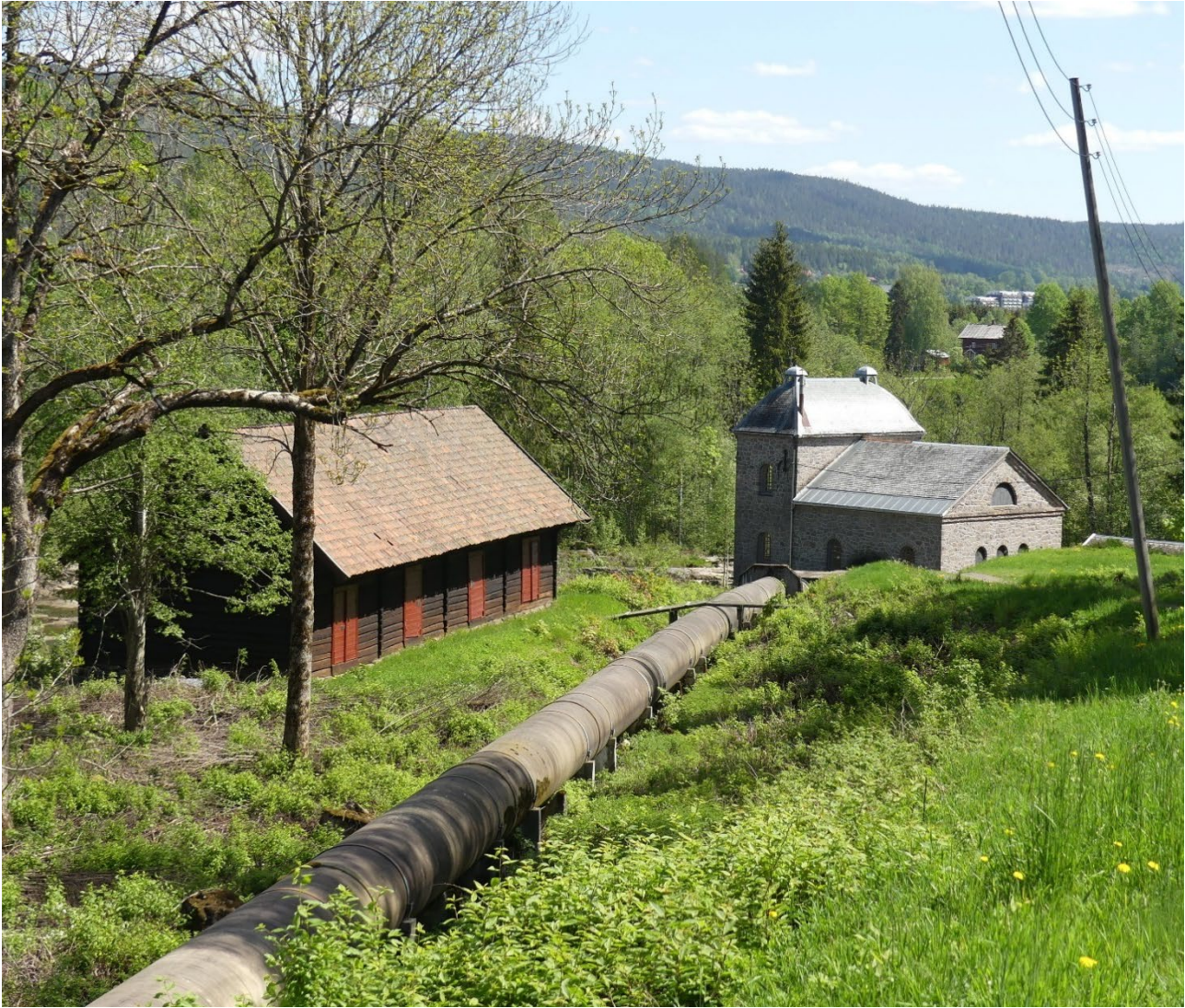
Figur 47: Kraftstasjonen og "Jernbua" tilhørende Hakadal verk er eksempler på bygninger i kategorien «andre hustyper». Foto: HT/ASPLAN VIAK 2021
