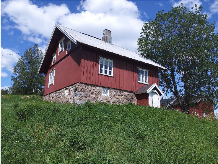
Figur 20: Utskifting av takteking, som her fra tegl til metallplater, er en mindre endring (C). Foto: HT/ASPLAN VIAK 2021 (2330009004).
