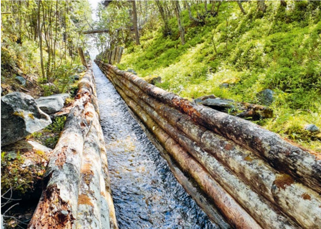
↑ Flotingskanal for floting av tommer. Flotningskanalene mellom Femunden og Feragen ble bygget av Røros kobberverk på 1760-tallet. Anlegget består i dag av fire tommerrenner. Foto: Hanna Geiran, Riksantikvaren
