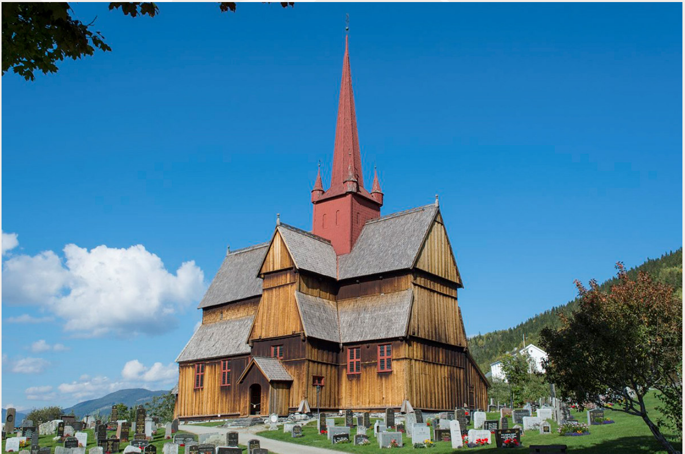
Ringebu stavkirke. Foto Dagfinn Rasmussen / Riksantikvaren
