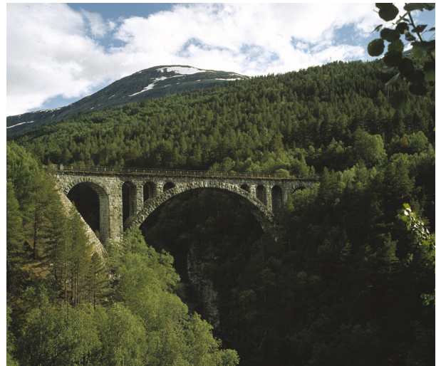
Kylling bru, Raumabanen. Foto: Møre og Romsdal fylkeskommune.
