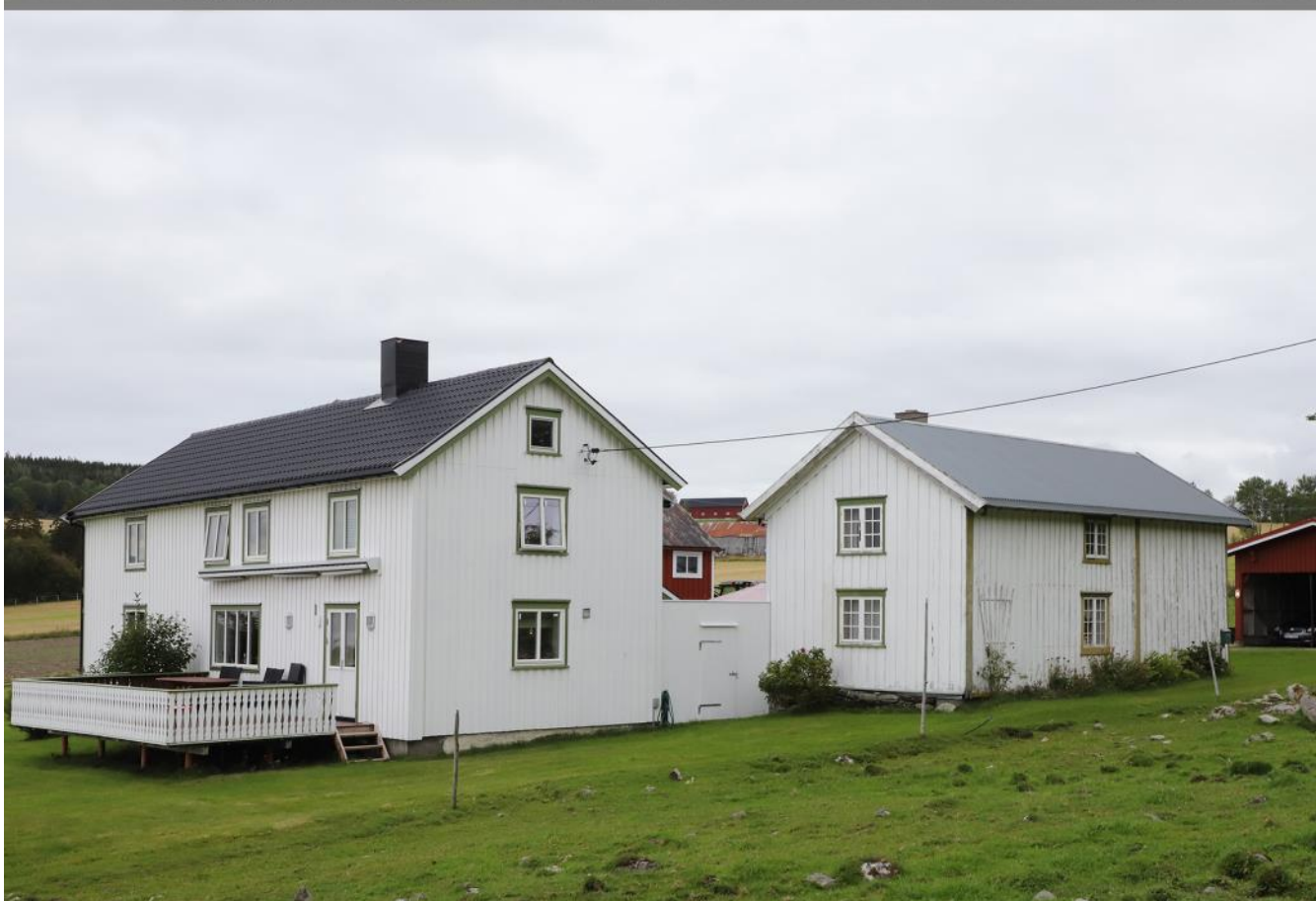
Rønningen gård. Bildene viser et nokså stabilt bygningsmiljø gjennom 110 år. Frostating, Frosta kommune, Trøndelag. Foto: 1910 NN (utlån Turid Viktoria Rønningen), 2021 Oskar Puschmann
