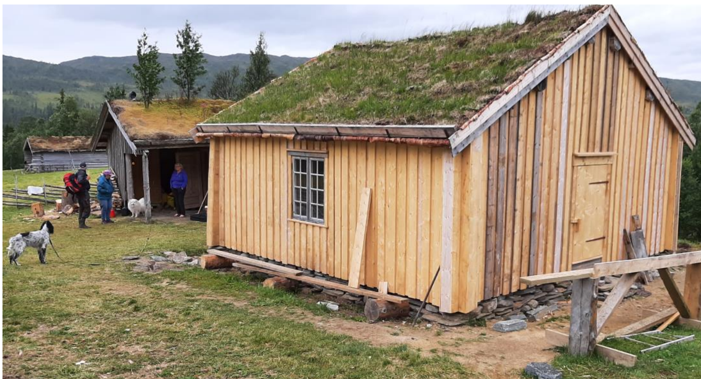
Seterstua ferdig istandsatt utvendig. Foto: Ottar Bergli.
