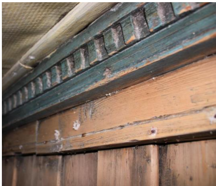
Interiøret i Agnesstua har gjenbruk av listverk og panel fra gammelkirka på Røst, som ble revet omkring 1900. Flere bygg i dette området har materialer fra gammelkirka. Foto: Einar Stamnes, Kulturminneplan for Røst kommune 2017-2022
