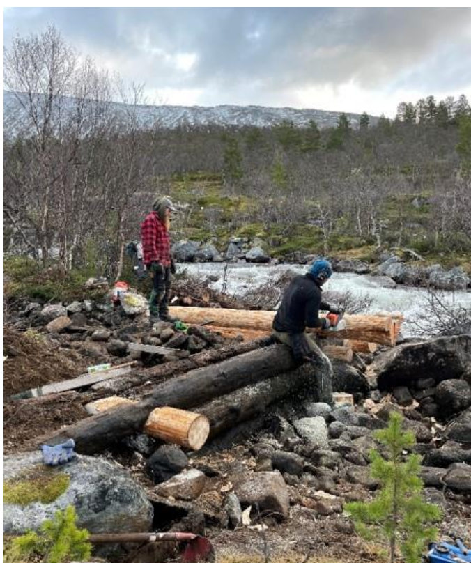
Bygging av ny dam. Foto: Kari Marie Jenstad
