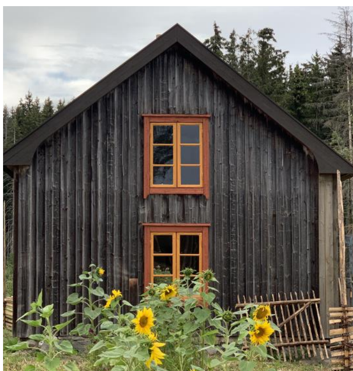
Gavlveggen etter istandsetting. Foto: Marianne Olssøn
