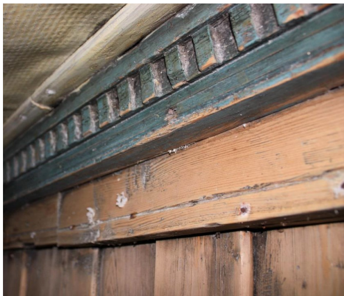
Interiøret i Agnesstua har gjenbruk av listverk og panel fra gammelkirka på Røst, som ble revet omkring 1900. Flere bygg i dette området har materialer fra gammelkirka. Foto: Einar Stamnes, Kulturminneplan for Røst kommune 2017-2022
