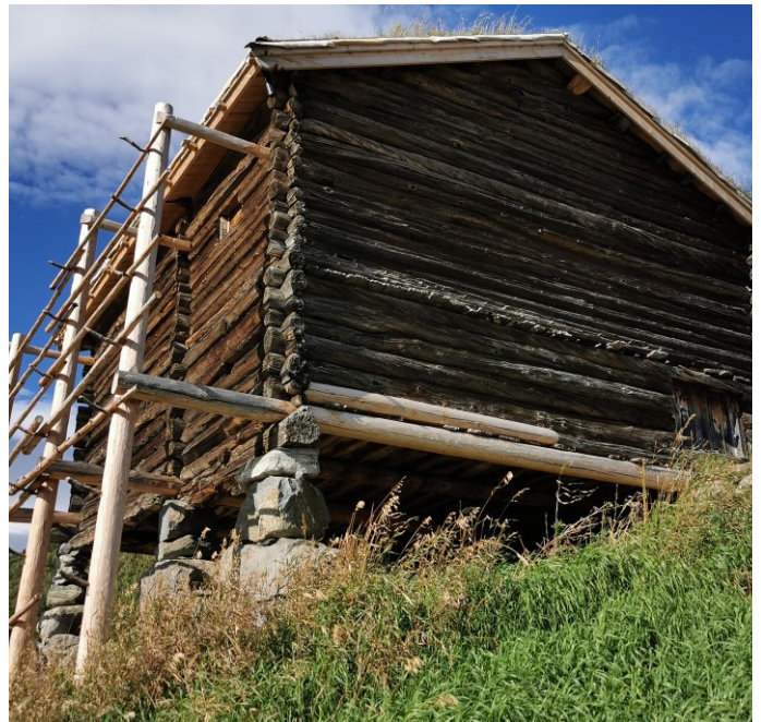
Istandsatt låve med utvendige kornhesjer. Foto: Stig Horsberg, Statsforvalteren i Innlandet
