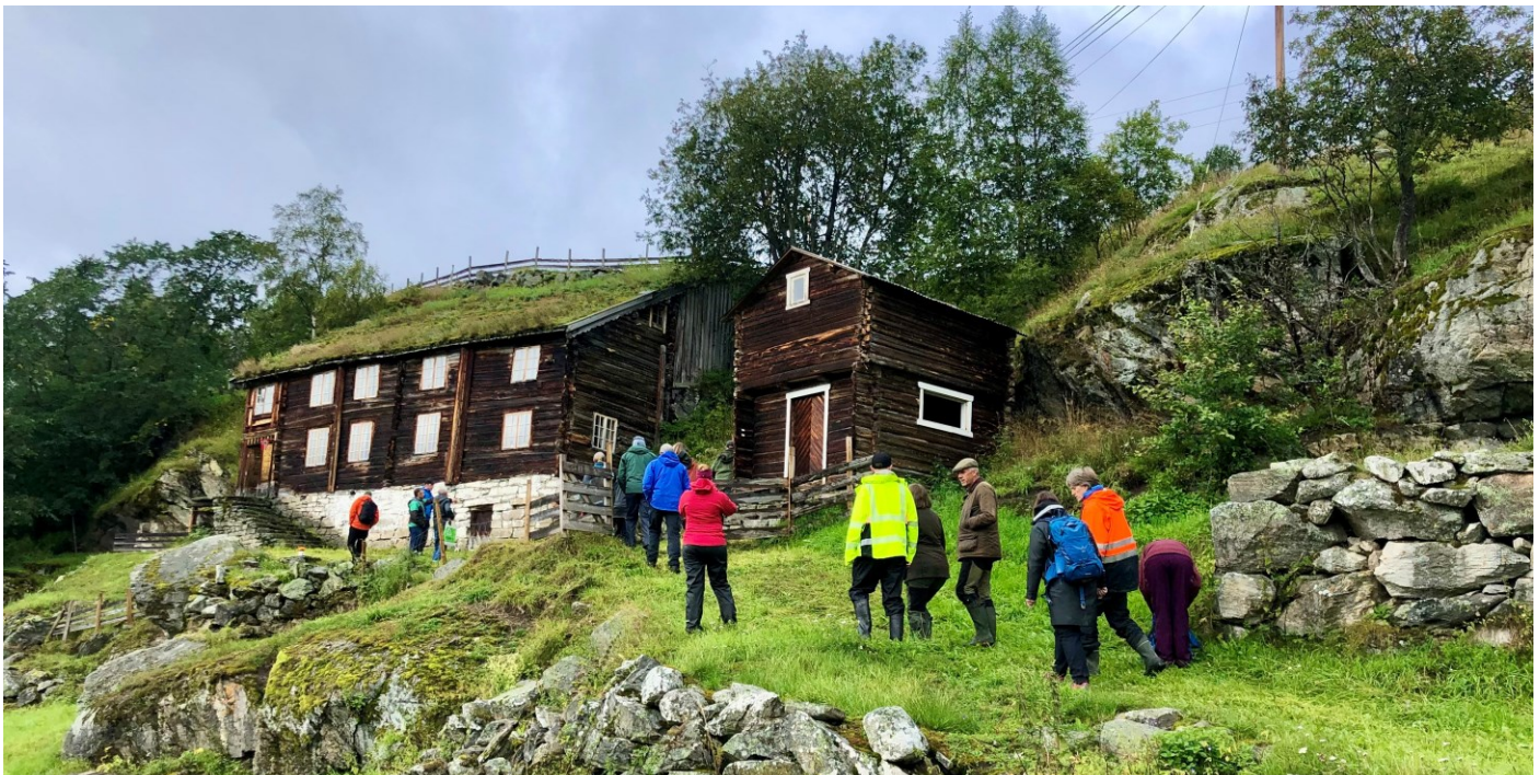
Grunneier John Kletthammer fortalte den sterke historien om det 1000 meter brede snøraset som i februar 1868 tok 32 liv. Dette våningshuset fra 1870 ble bygget inn mot en fjellskrent, slik at snøskred går over taket. Foto: Ragnhild Hoel
