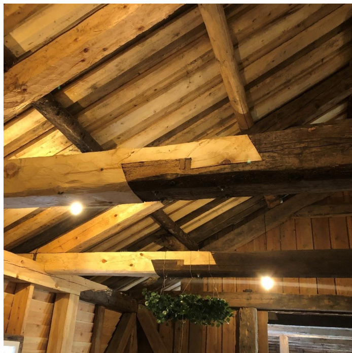
Detalj fra restaurering av den store låven på Furøya. Foto: Ellen Eskeland, Statsforvalteren i Agder
