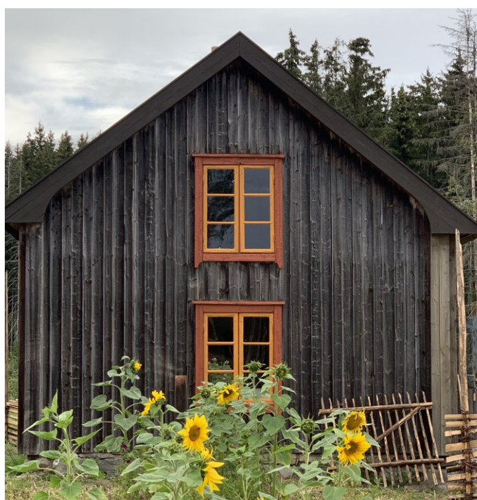
Gavlveggen etter istandsetting. Foto: Marianne Olssøn
