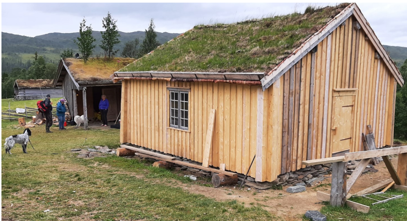
Seterstua ferdig istandsatt utvendig. Foto: Ottar Bergli.
