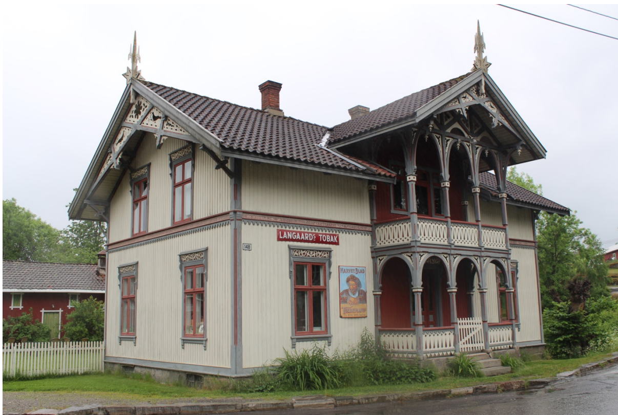
08210010001: Landhandelen Åheim ligger på Oterholt, som tidligere var bygdesenter i Bø. Bygningen er nå en del av Bø museum, som er regulert til spesialområde bevaring. Foto RM/NIKU 2014
