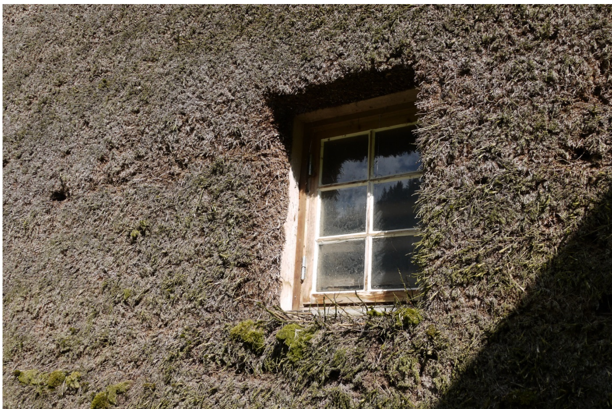
12420008034: Eksempel på fint istandsatt brakeløe. Foto: ÅD/NIKU 2014
