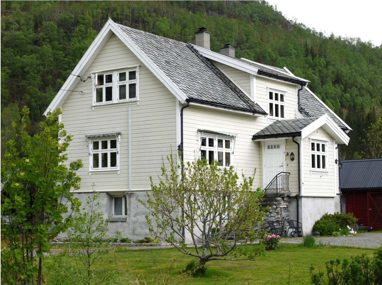
12420007050: 48 % av de SEFRAK-registrerte bygningene i Samnanger kommune er endret. For 25 % dreier det seg om overflateendringer og vedlikehold av fasade og tak, eller utskifting av vinduer, som på dette huset. Foto: ÅD/NIKU 2014
