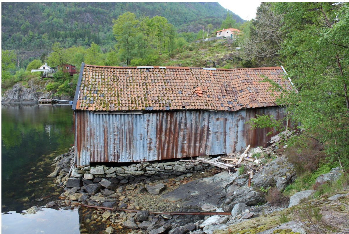
12420002096: SEFRAK-bygningene i undersøkelsen er fra en tid da fjorden var den viktigste kommunikasjonsåren i Samnanger kommune. Naust og sjøhus utgjorde 8 % av undersøkelsesgrunnlaget i 3. omdrev. 2 av til sammen 26 bygninger var tapt og 3 er registrert som truet, men ingen er sterkt truet. Foto: RM/NIKU 2014
