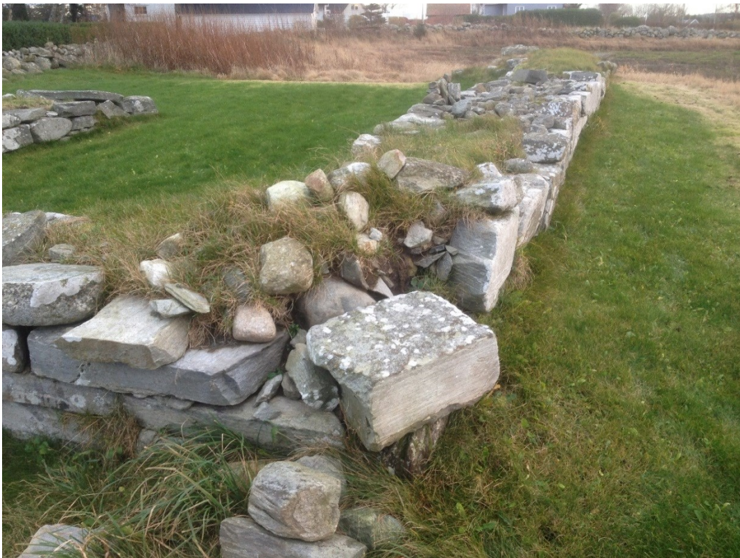
Fig.4. Kirkeruin på Viste i 2014, sett fra sørvest. Kollaps av det sørvestlige hjørnet som fører til at murkjernen blir eksponert og uten støtte.
