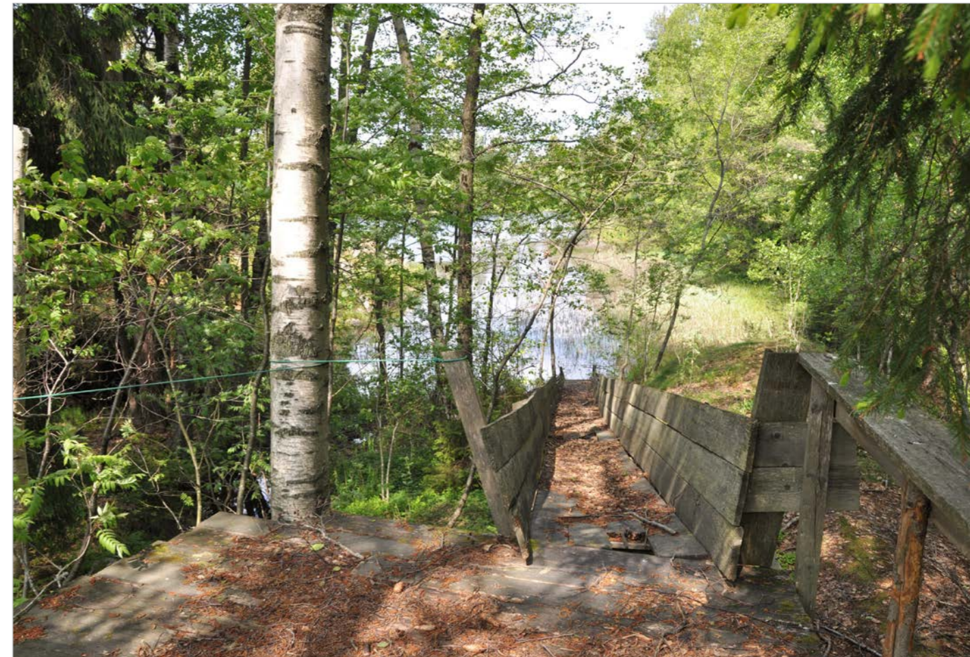
Nydammen med synlig isrenne. Foto: NVE, Helena Nynäs
