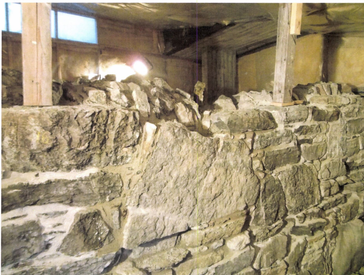
Steinblokka endelig på plass i muren
