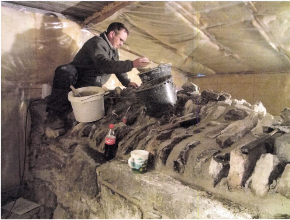
Muring av toppdekke
