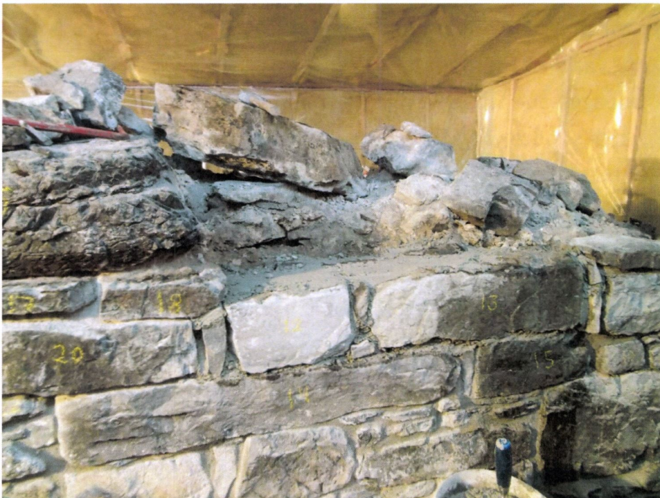
Samme murvange under oppmuring med kalkmørtel
