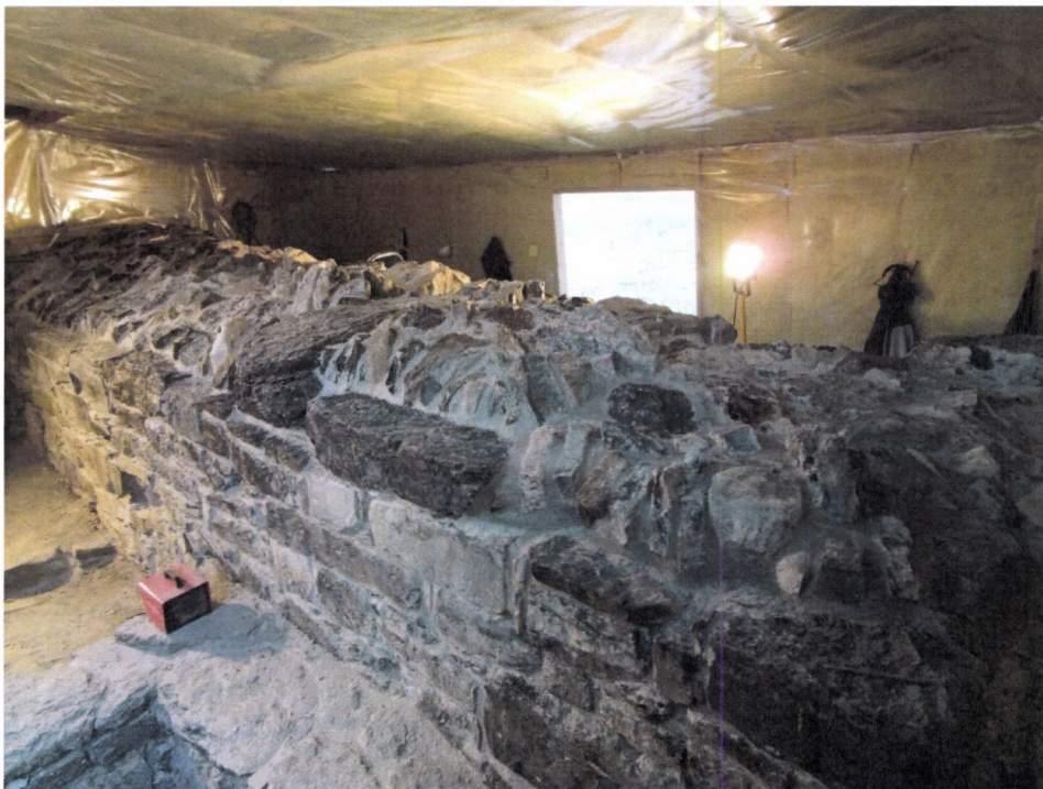
Mur med toppdekke ferdig 19.12
