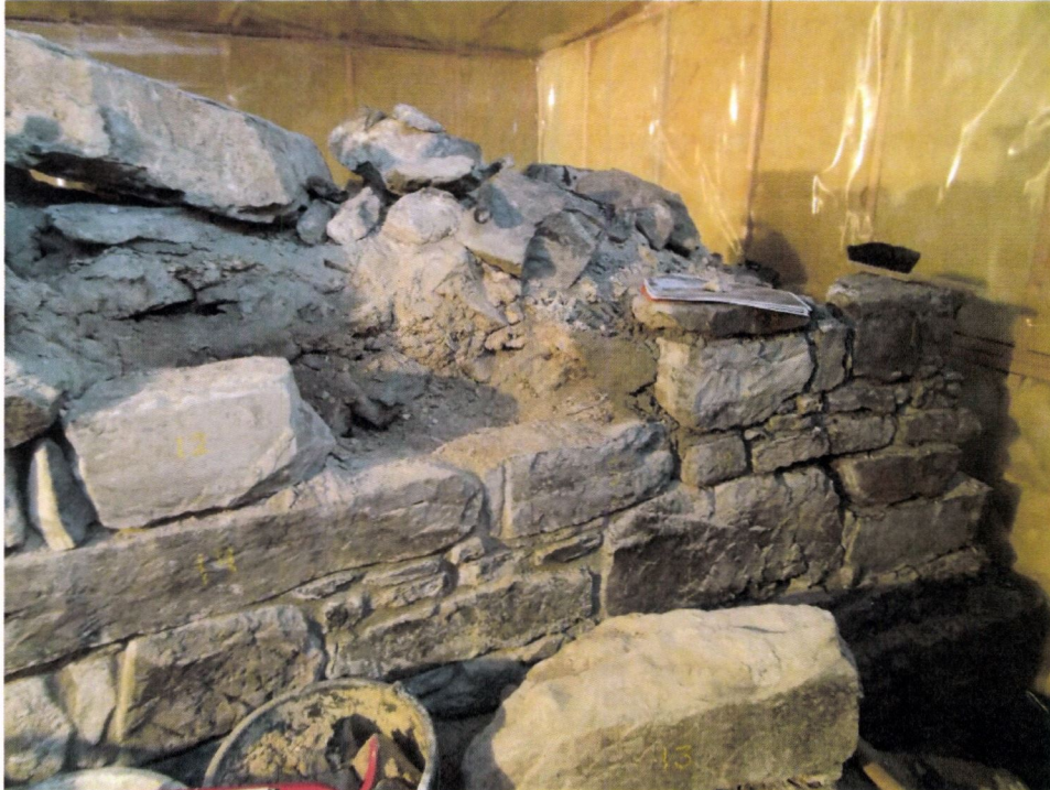
Murvange mot vest, tatt ned til opprinnelig bevart nivå
