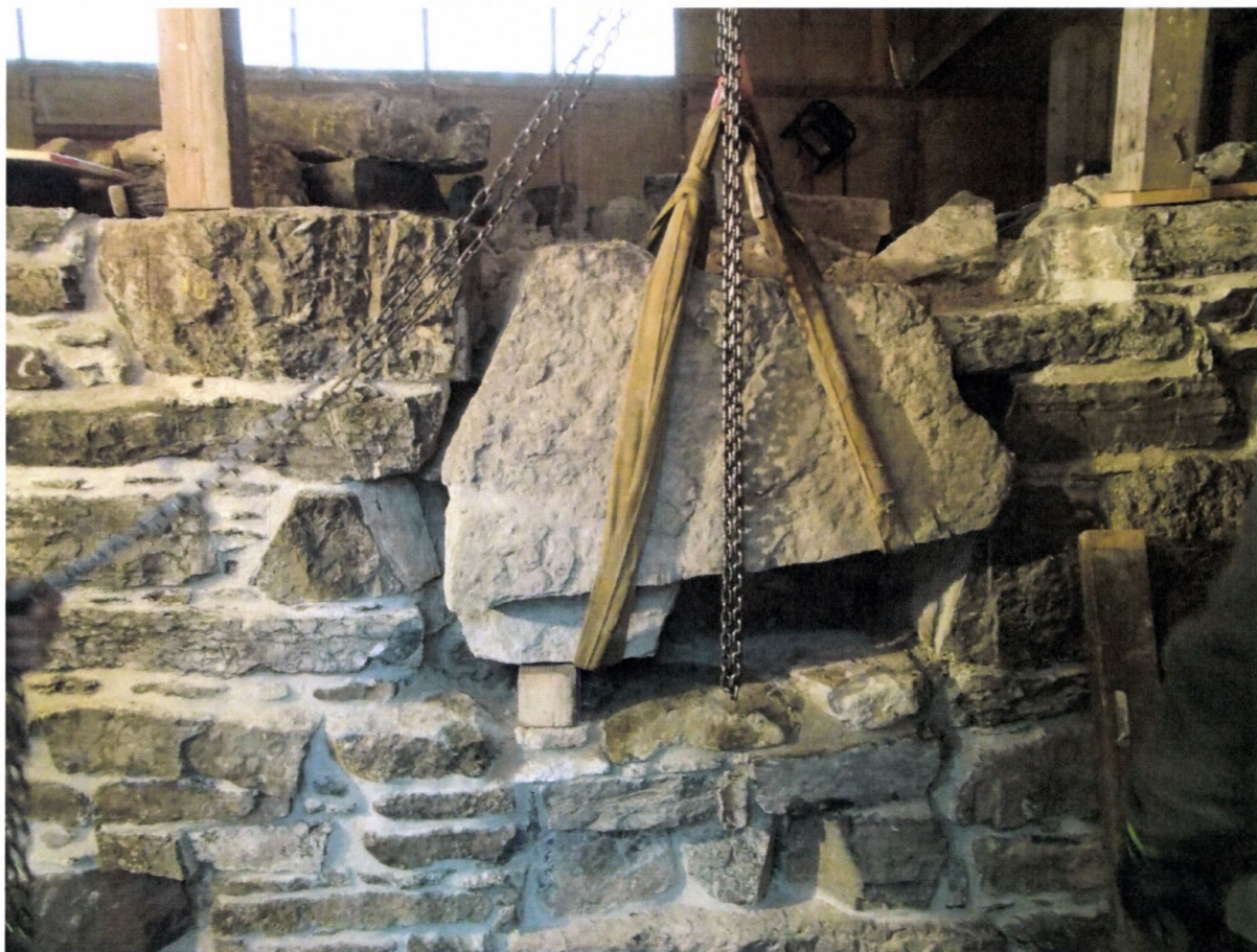
Ferdig limt blokk i murens østre vange heises på plass
