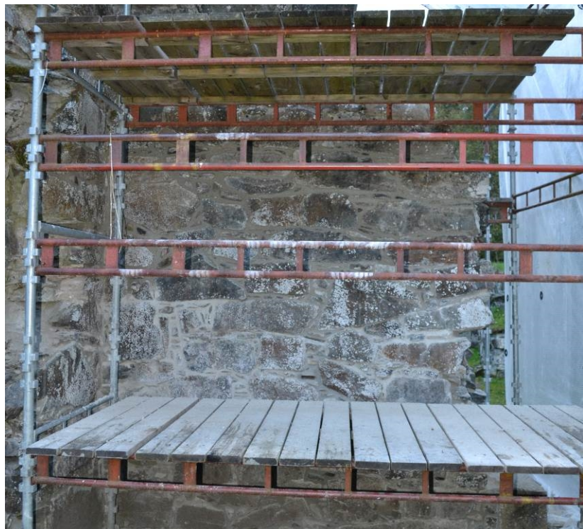
Foto 20050624_017 og _018 Utvendig i hjørnet mellom kor og nordre korsarm etter at spekking og pinning av murverk er utført
