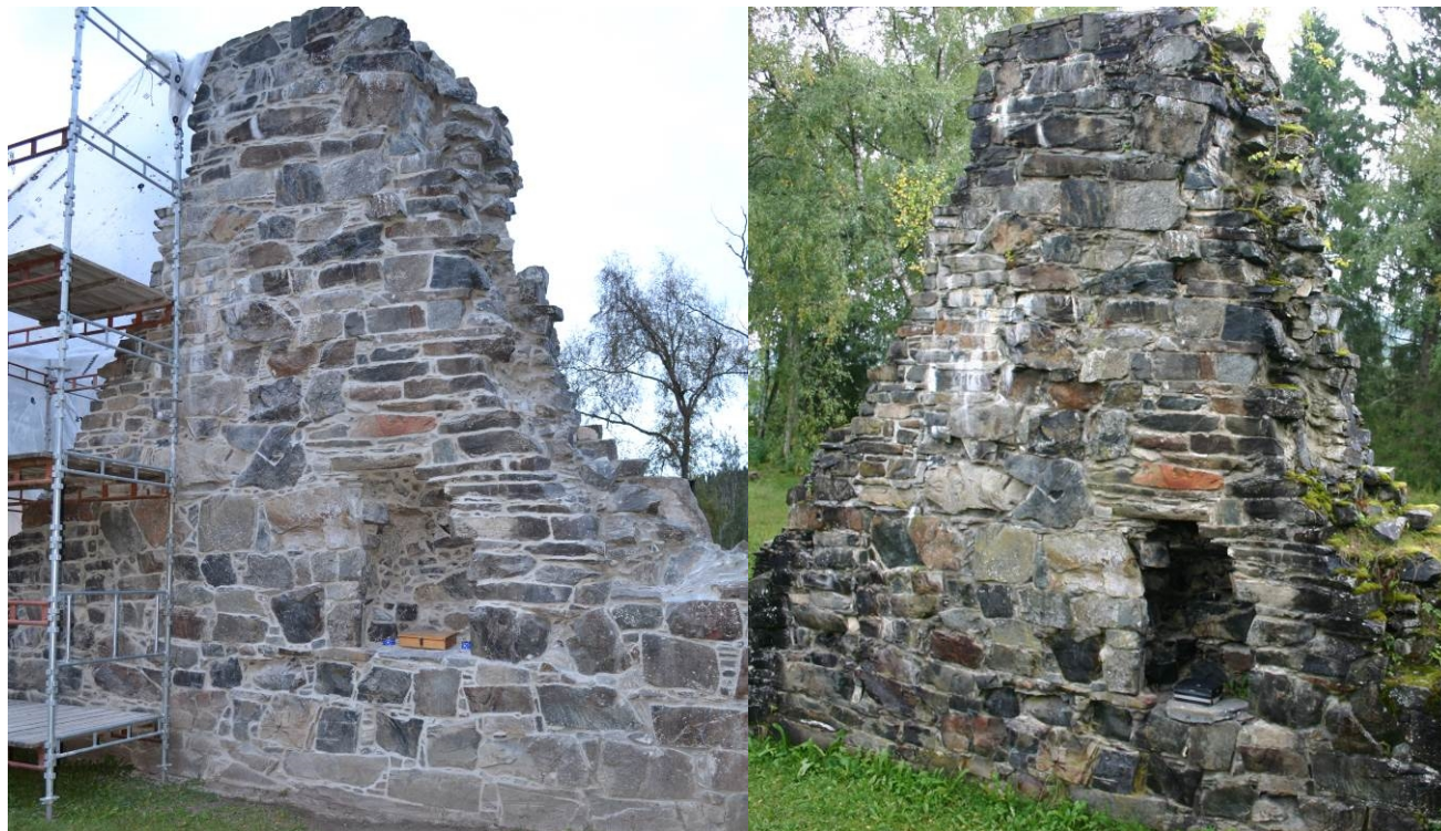
Munkeby klosterruin før og etter konservering i 2014
