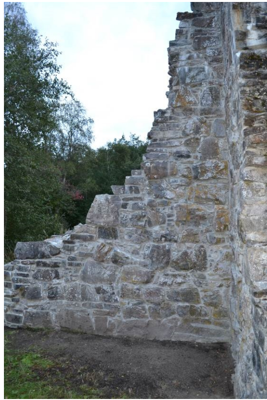
Foto 20050624_017 og _018 Utvendig i hjørnet mellom kor og nordre korsarm etter at spekking og pinning av murverk er utført
