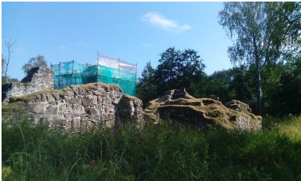
Foto fra dagbok. Nordre korsarm tildekket for meisling og spekking før oppstart i 2014
