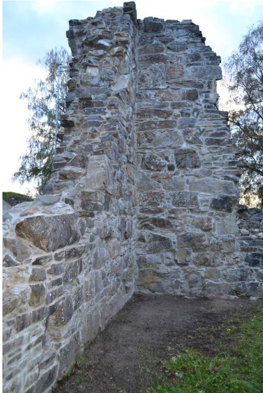
Foto 20050624_017 og _018 Utvendig i hjørnet mellom kor og nordre korsarm etter at spekking og pinning av murverk er utført
