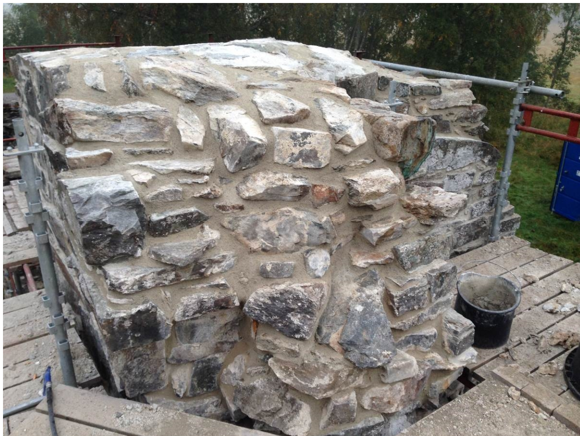
Foto fra dagbok: Muring av toppdekke på Munkeby klosterruin.
