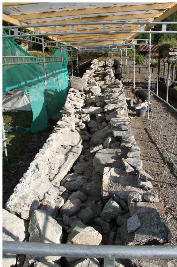
Figur 4. Den opprinnelige murkjerne er eksponert (foto: Byantikvaren 2014).
