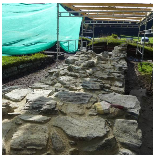
Figur 11. Ny toppdekning på vestmuren med «åpen» murkjerne (foto: Byantikvaren 2014).
