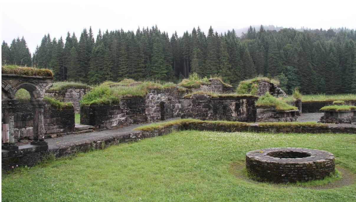
Figur 12. Murkronene på Lyse har siden 1920-årene hatt overdekning av torv. Valg av torvoverdekning på murene kan sies å være en bevisst videreføring av hvordan ruinen har fremstått i århundrene etter at bygningene ble revet på 1500-tallet (foto: Byantikvaren 2013).
