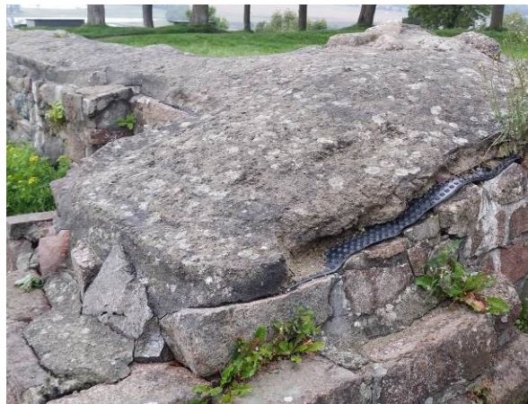
Figur 16. Ruinmurene i Mikaelkirken i Tønsberg er avsluttet med et sementdekke, en såkalt «flystripe». Mellom sementdekket og murkjernen er det lagt plastmembran (foto: Byantikvaren 2014).
