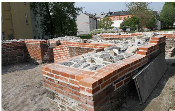
Figur 13. Nylig istandsatte ruinmurer med åpen murkjerne i Olavsklosteret i Oslo (foto: Byantikvaren 2012).
