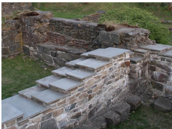
Figur 15. På hovedøya i Oslo er murkronene på deler av klosterruinen avsluttet med skiferheller (foto: Byantikvaren 2010).
