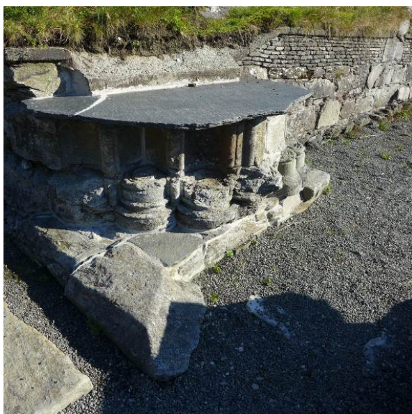
Figur 10. Ny overdekning på portalbasene ved Kapittelsalen (foto: Byantikvaren 2014).
