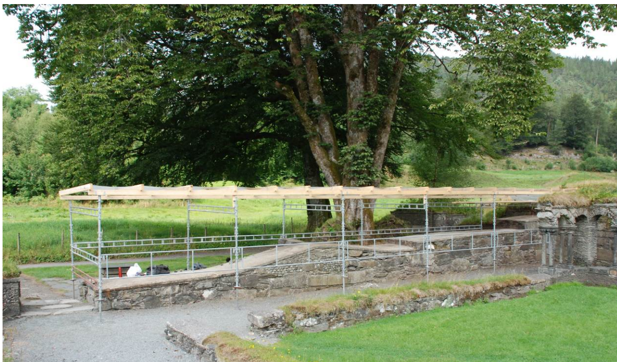
Figur 2. Torvoverdekningen på murkronen til vestmuren er fjernet og sementdekket eksponert (foto: Byantikvaren 2014).
