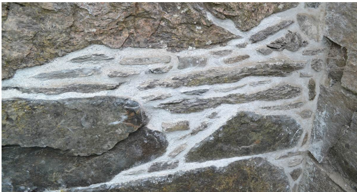
Foto 20052208_024: Spekking og pinning av murverk på Lyse klosterruin.
