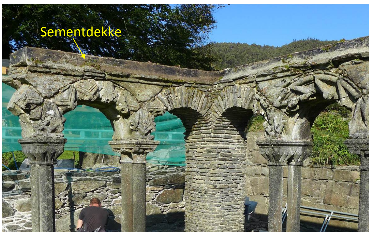
Figur 9. Arkaderekken på Lyse er en rekonstruksjon fra 1930-årene. På bildet er torven på murkronen fjernet og det solide sementdekket under er eksponert. Sementdekket antas å ha en avstivende effekt for konstruksjonen (foto: Byantikvaren 2014).
