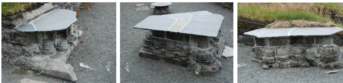
Figur 8. Portalbasene til kapittelsalen ferdig istandsatt. Sementfugene er erstattet med kalkmørtel og det er montert en vanntett toppdekning av skiferheller (foto: Byantikvaren 2014).
