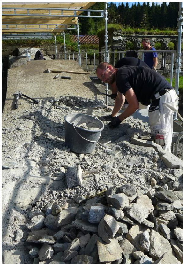
Figur 3. Sementdekket ble fjernet med hammer og meisel (foto: Byantikvaren 2014).
