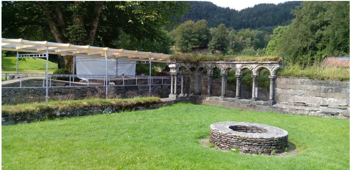
Foto 20140804_152: Toppdekke rensert for jord og vegetasjon. Tak over ruinen er montert og meislingsarbeidet startet.
