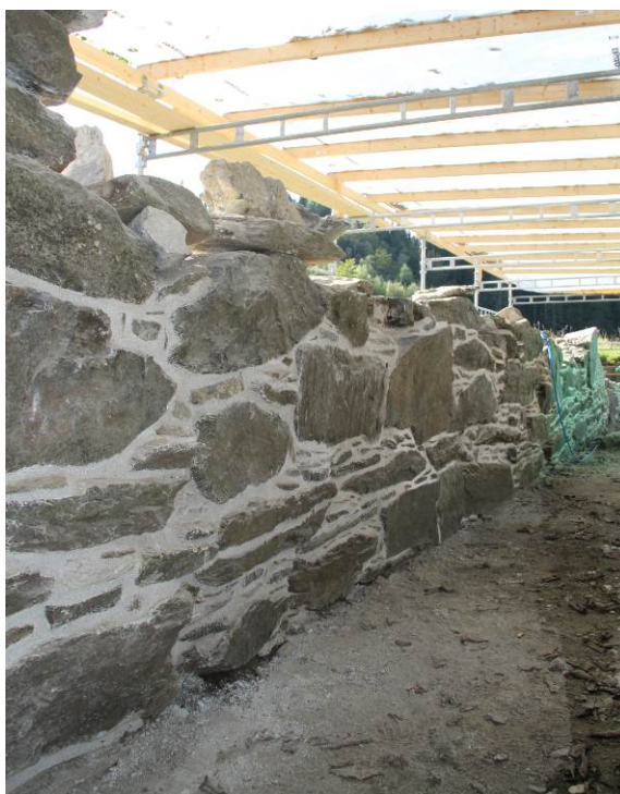
Figur 6. Sementfugene i murlivet ble erstattet med fuger av kalkmørtel. Murliv mot vest (foto: Byantikvaren 2014).
