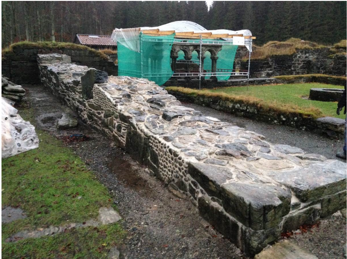
Foto 20052210_134: Vestmuren på Lyse klosterruin ferdig spekket og med murt nytt toppdekke. Bildet er tatt i desember 2014 etter at tildekking ble fjernet.
