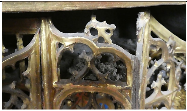
Detalj av masverk. Støvet ligger tykt inne i konstruksjonen.
