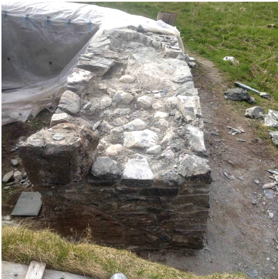
Foto fra dagbok IMG 0655 siste del av murverket i sakristi under arbeid.
