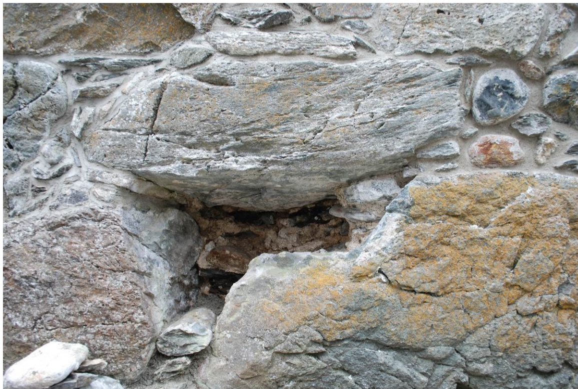
Foto 20050723_001 Eksempel på området i sakristi mot vest som er ferdig meislet og rensset. Pinningsstein er tatt ut og mures tilbake på sin opprinnelige plass. I bakkant av fuge sees original fast kalkmørtel i kjernen. Området rundt hullet i muren er ferdig spekket.
