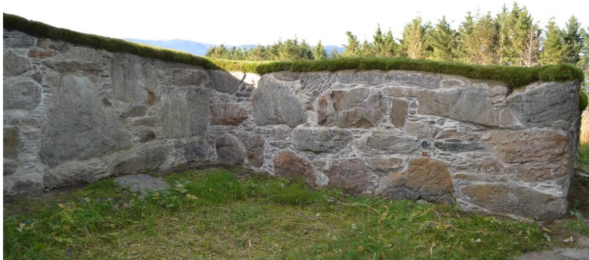
Foto 20050723_044. Vegger i sakristi mot vest ferdig spekket.
