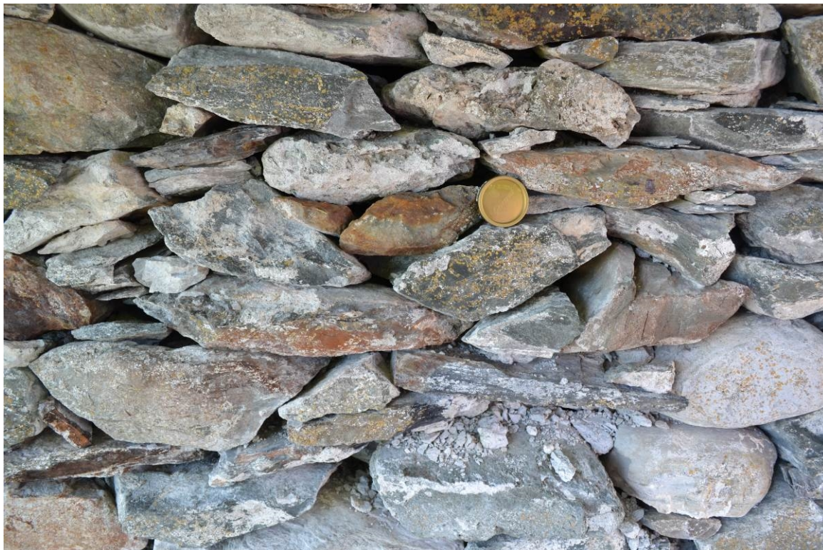
Foto 20050723_031 Eksempel på murverk som ble demontert 2014.
