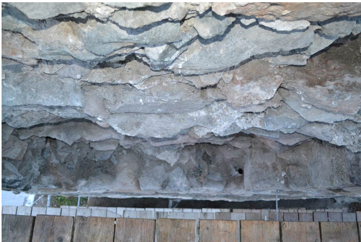
Foto 20050723_055 Ytre del av mur demontert sett ovenfra og ned.
