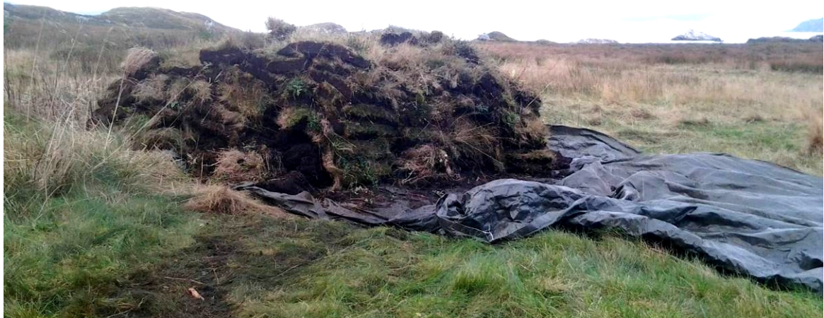
Foto IMG_0733: Torv som skal tilbakeføres på ruinens toppdekke etter fuktsikring av toppen
