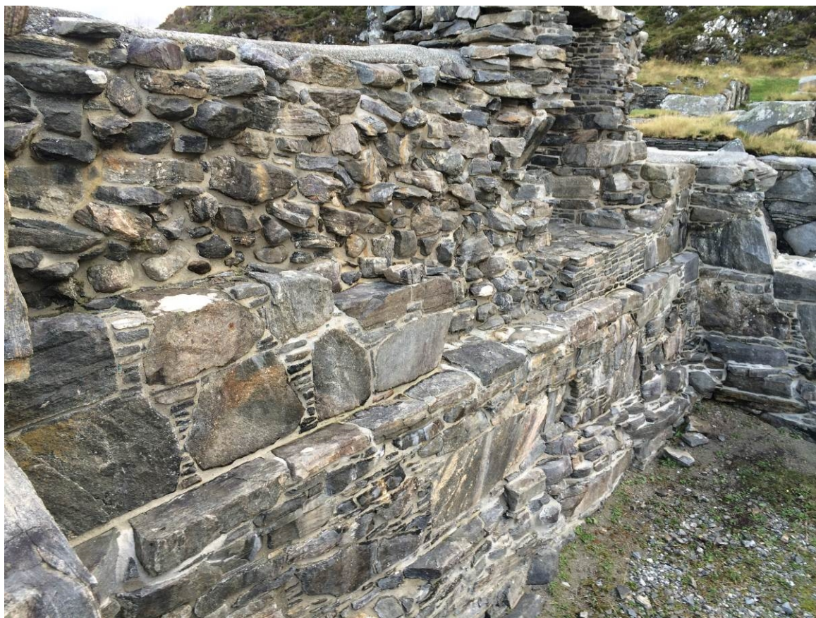
Foto fra I-Phone IMG_2916: Ferdig spekket vegg i L-3. Alle rommets veggflater og overganger mellom toppdekket og murvanger er ferdig konservert.
