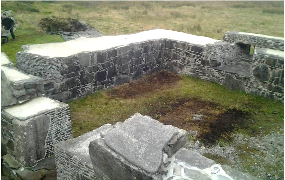
Foto IMG_0738: L-3 ferdig spekket og pinnet i 2014. Rommene L1-L3 er ryddet for torv og vegetasjon.
