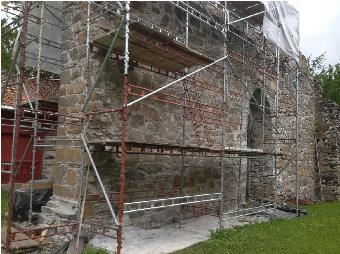
Foto IMG_1025: Rein klosterruins vestvegg 2014. Søndre halvdel er under arbeid med spekking og muring av nytt toppdekke murt. Nordre halvdel er ferdig grovmeislet.
