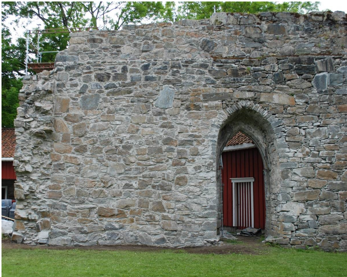
Foto 20050150_004 Vegglivet ferdig spekket i 2014. Stillaser ble demontert i forbindelse med et arrangement i Rissa kommune sin regi i juni 2014.
