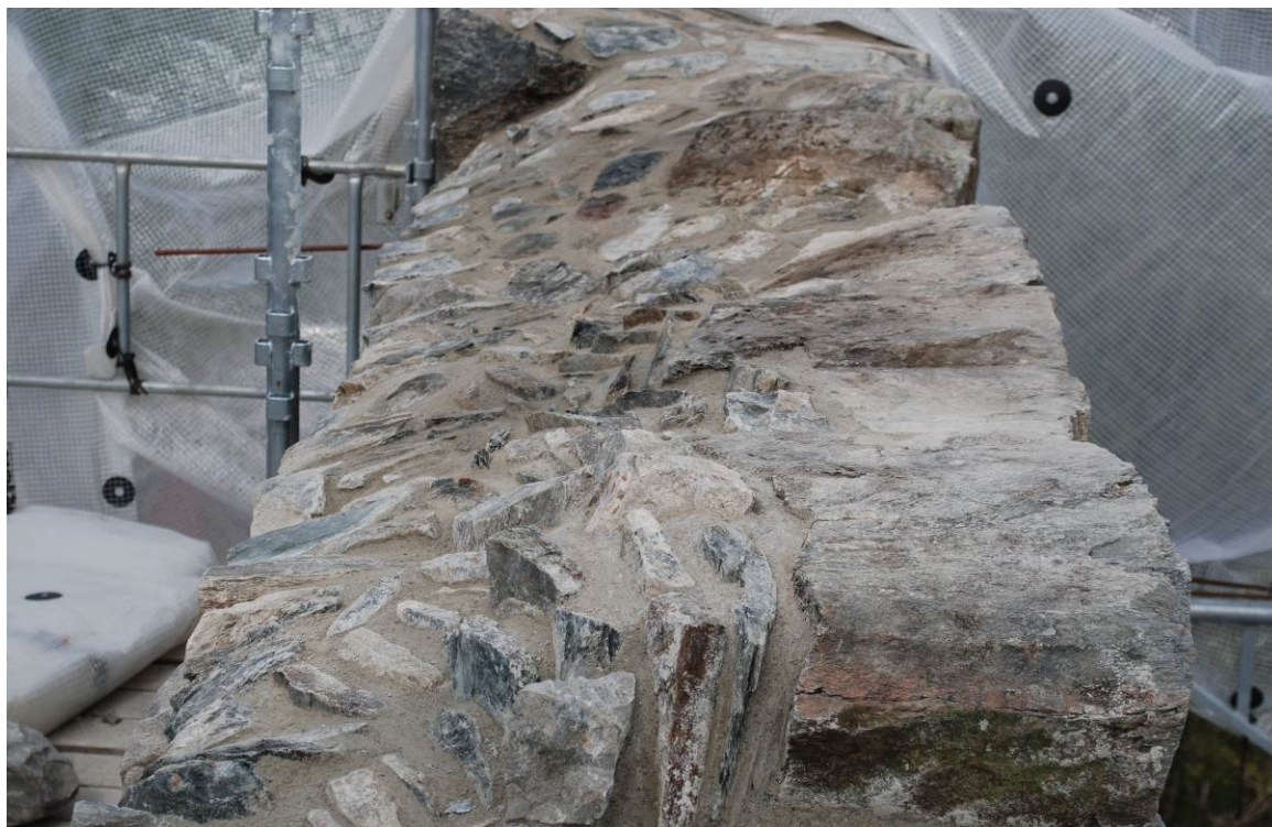
Foto 20050150_001d: Øvre toppdekket på omtrent halve vestveggen ferdig.
