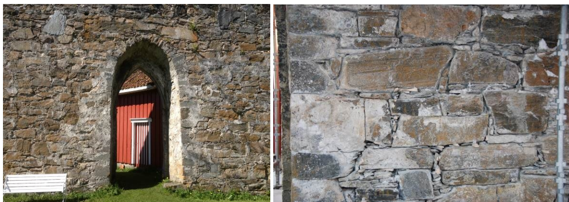
Foto 20050146_153 og 0149_002: Bildet til venstre viser deler av vestveggen før meisling. Bildet til høyre viser etter grovmeisling med meiselmaskin.
