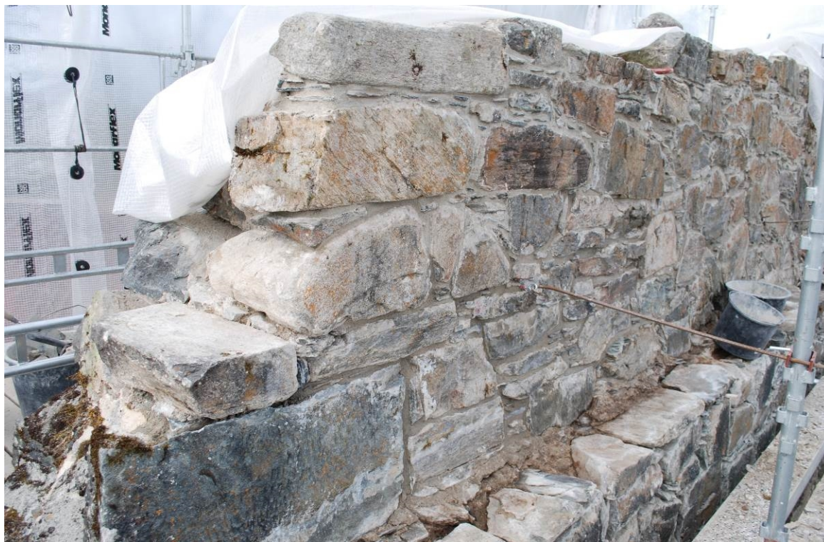
Foto 20050150_001. Toppdekke med avsatser. Øvre toppdekket er ferdig, nedre avsatser er meislet og rensset.
