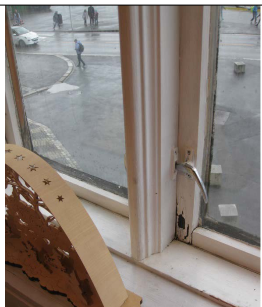
Detalj fra kopivindu i 3.etasje. Foto: NIKU
