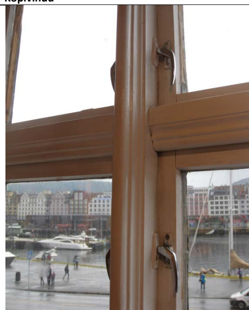
Detalj fra kopivindu i 3.etasje. Foto: NIKU
