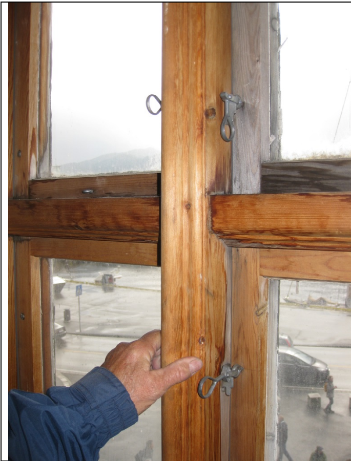
Vindu på loftet. Foto: NIKU
