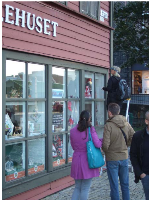
Bygning 9A. Vurdering av nedre deler av fasaden
