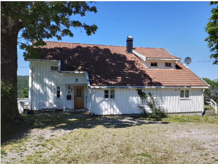
Figur 18: Eksempel på stor endring (A). Større ombygging og utvidelse av bygningens grunnflate, slik at bygningens opprinnelige volumkarakter er endret. Foto: SBF/ASPLAN VIAK 2020 (9110206001)
