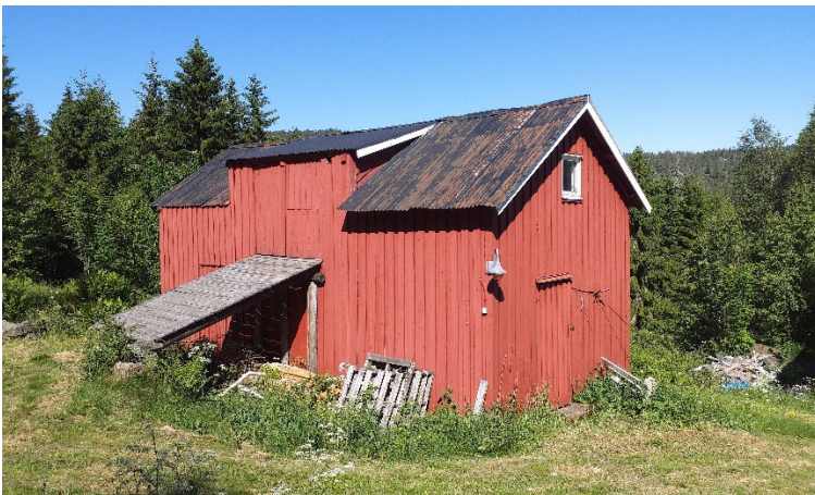
Figur 28: De gamle driftsbygningene i tilknytning til tunet, har den høyeste, akkumulerte tapsandelen i Gjerstad. Foto: HT/ASPLAN VIAK 2020 (167483615)
