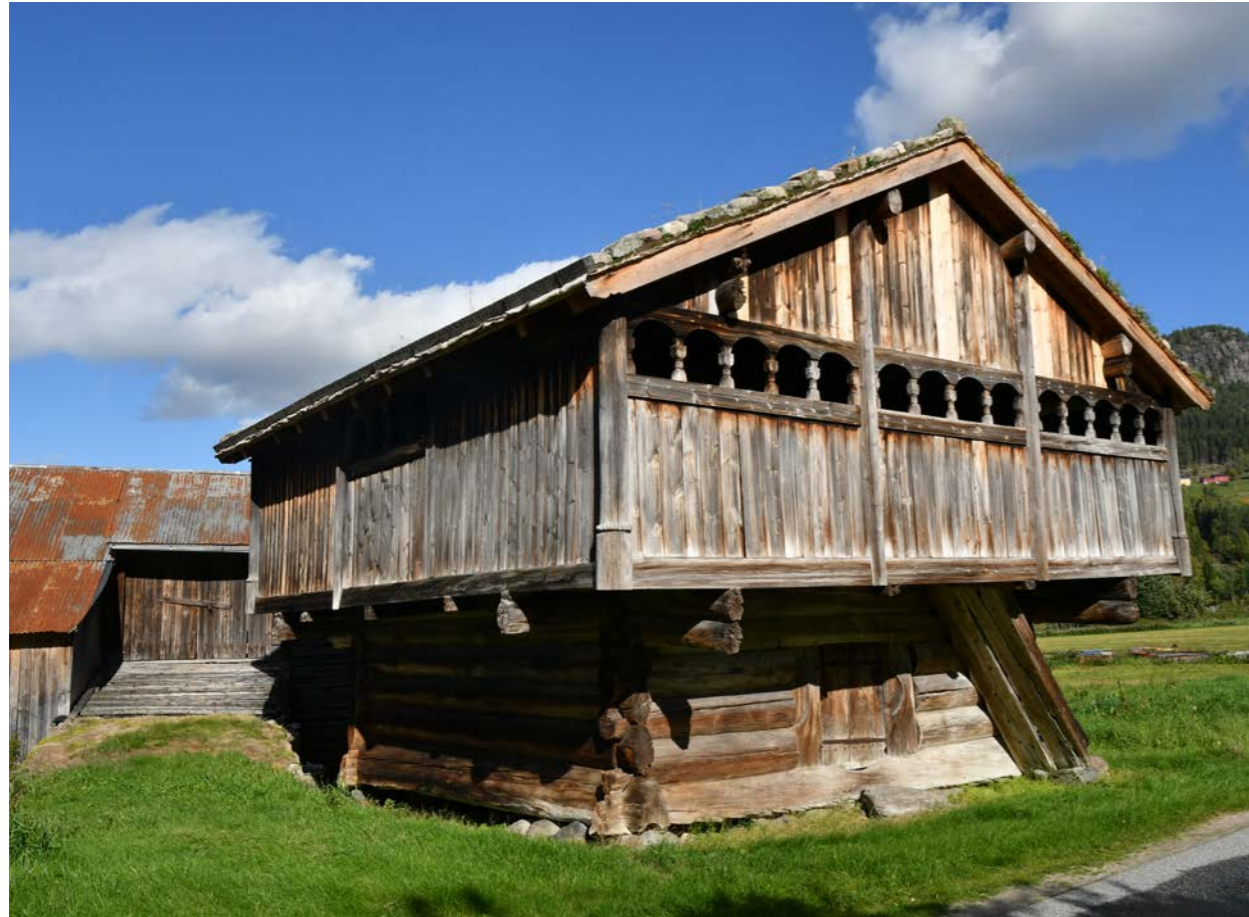
Haugeburet på Nordre Haugen. Buret er fra 1218 og er det eldste av flere bur i Åraksbø. Foto: Bjarne Tresnes Sørensen, Agder fylkeskommune.
