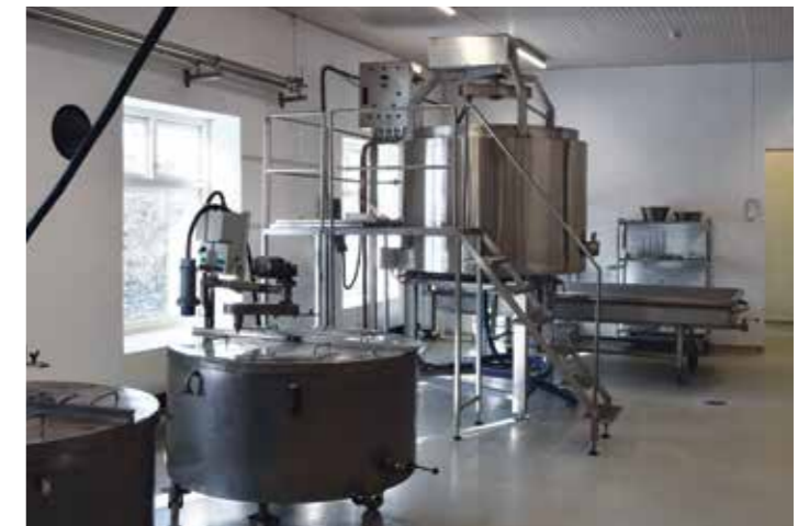
Et topp moderne ysteri har tatt plass i det som var et nedslitt traktorverksted for få år siden.
