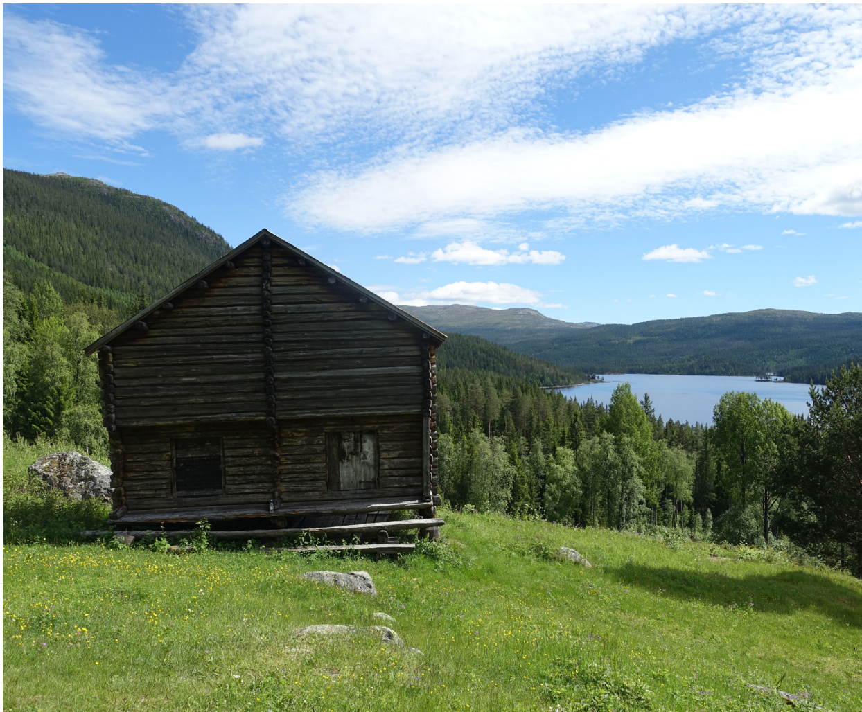
Stabburet på Vassfarlassen, med utsikt ut over Nevlingen. Foto: Jørn Jensen, Viken fylkeskommune
