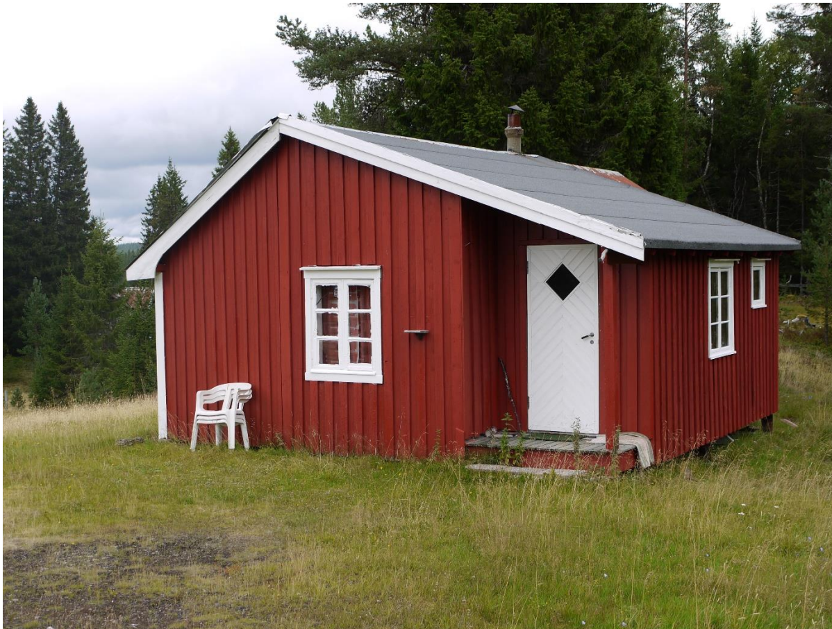
49 SEFRAK-registrerte utmarkshus ble undersøkt i Melhus i 2018. To var tapt, og fem av de gjenstående var truet av forfall. Utmarkshusene har relativt få endringer (36 %) (16530024070). Foto: ÅD/NIKU 2018
