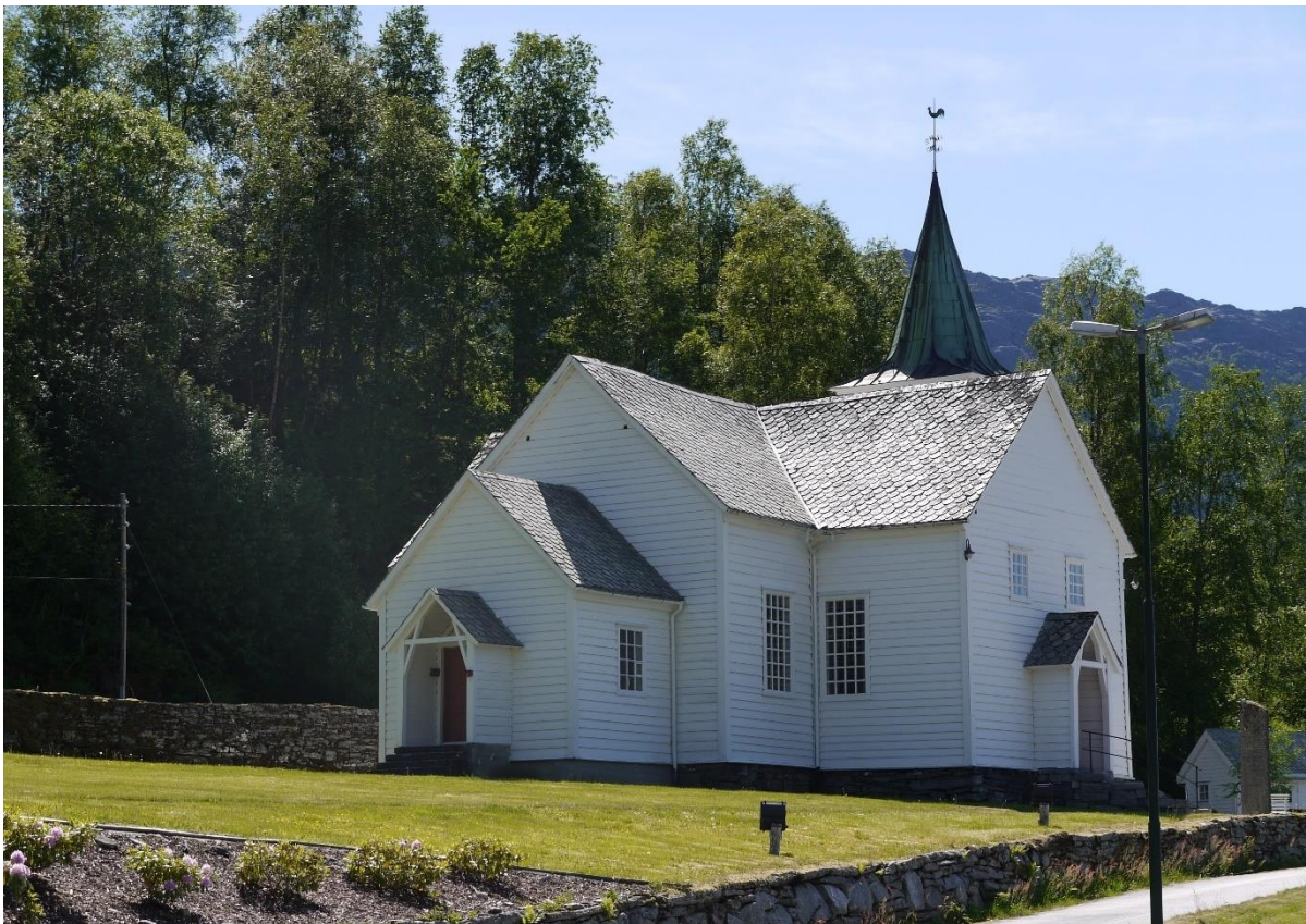
Eikefjord kyrkje er listeført av Riksantikvaren og inngår i kontrollen av verneverdige kulturminner i overvåkingsprogrammet. Kirkebygningen ble registrert i god stand. Foto: ÅD/NIKU 2018
