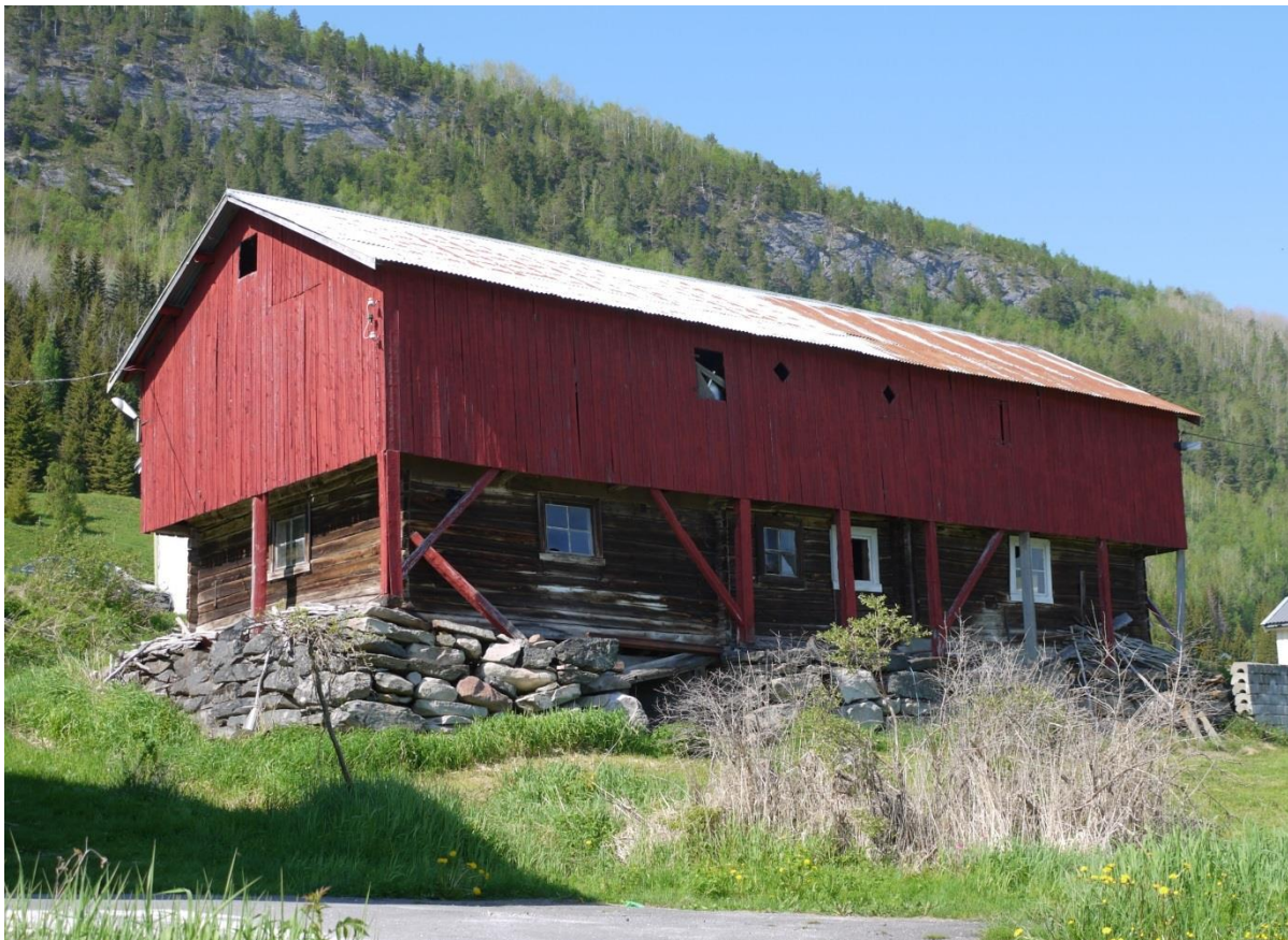
Rundt 14 % av SEFRAK-bygningene i Saltdal er større driftsbygninger. Både tapsandel og forfall ligger noenlunde på gjennomsnittet for kommunen. Karakteristisk for de store driftsbygningene er imidlertid at en stor del av endringene er volumendringer, som tyder på brukstilpasninger (18400101034). Foto: ÅD/NIKU 2017
