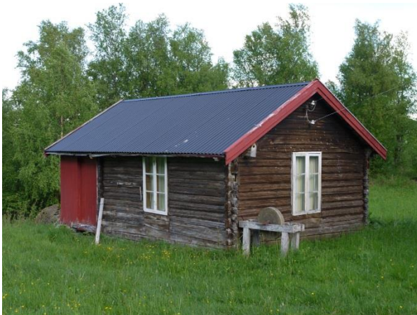
Venstre: Overflateendringer, som ny type takteking, registreres som C-endring (18400101043). Høyre: Maling, eller skifte av panel i samme stil som før, regnes ikke som endring (18400109005). Av de gjenstående SEFRAK-bygningene i Saltdal er 24 % registrert med C-endringer, mens 55 % av bygningene er uendret. Foto: ÅD/NIKU 2017
