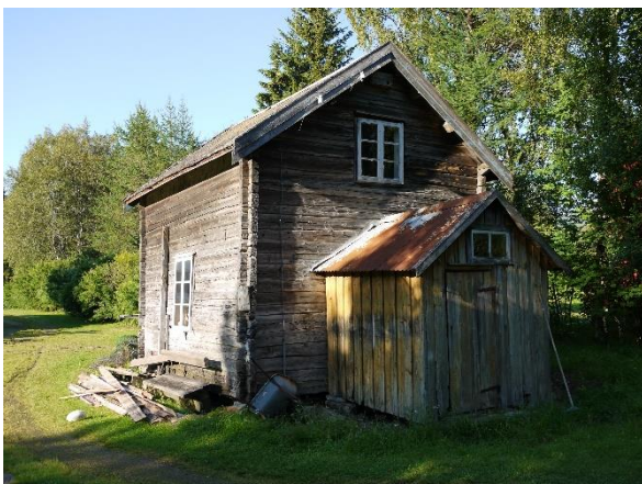
Deler av en bygning kan være bygd i en lettere konstruksjon, som ofte vil være mer utsatt for forfall enn den tømrete delen, slik som dette stabburet, fotografert i 2012 og 2017. I 2017 var inngangspartiet revet, og bygningen ble dermed registrert med B-endring (mindre volumendring), og i tillegg ble det registrert at deler av hus er revet (18400105092). Foto: ÅD/NIKU 2012 og 2017
