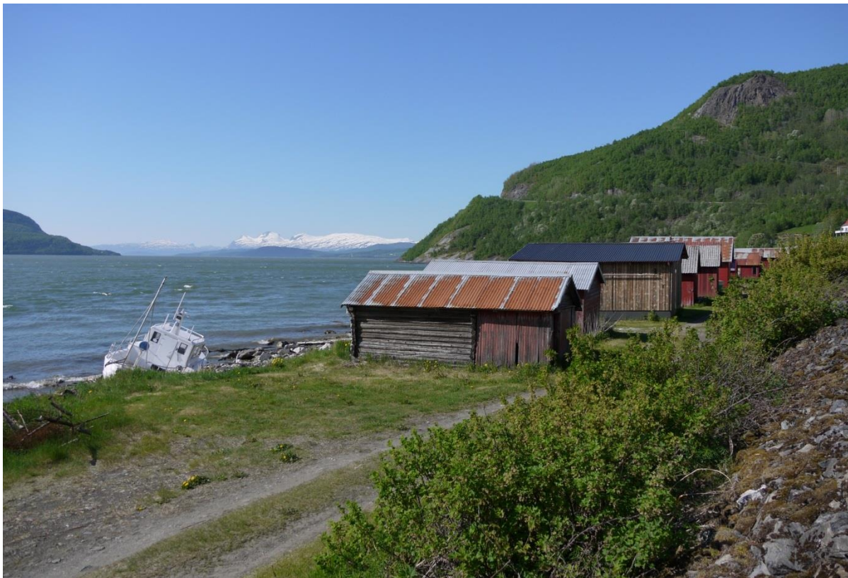
20 SEFRAK-registrerte naust inngikk i undersøkelsesgrunnlaget ved første kontrollregistrering i Saltdal i 2002. Syv av disse er tapt – ett var tapt i fjerde omdrev. Ingen av de 13 gjenstående er truet av forfall. Foto (18400109036): ÅD/NIKU 2017
