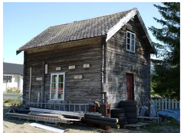
Deler av en bygning kan være bygd i en lettere konstruksjon, som ofte vil være mer utsatt for forfall enn den tømrete delen, slik som dette stabburet, fotografert i 2012 og 2017. I 2017 var inngangspartiet revet, og bygningen ble dermed registrert med B-endring (mindre volumendring), og i tillegg ble det registrert at deler av hus er revet (18400105092). Foto: ÅD/NIKU 2012 og 2017
