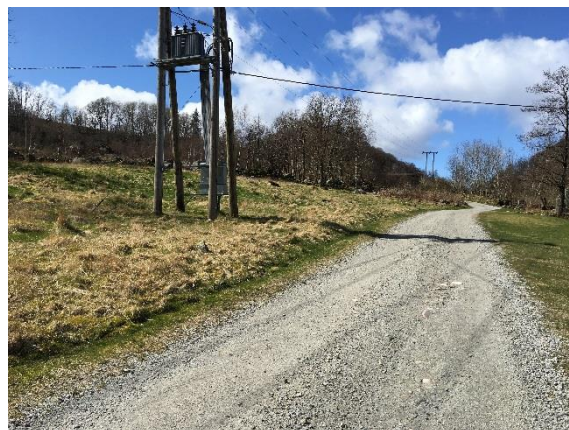
Figur 5-1 Rydningsrøyslokalitet på Selvik er registrert som skjemet på grunn av sammensatt skadeårsak (utvidet veg, master og planering i lokaliteten). ID: 5119.
