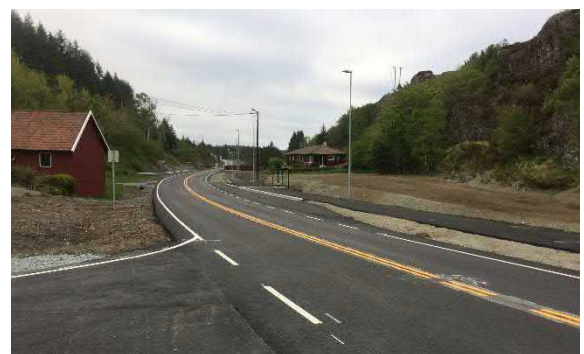
Figur 5-8 Bilde fra området med lokalitet ID 174290 fra mai 2018, som viser at veien er ferdig utbygget.
