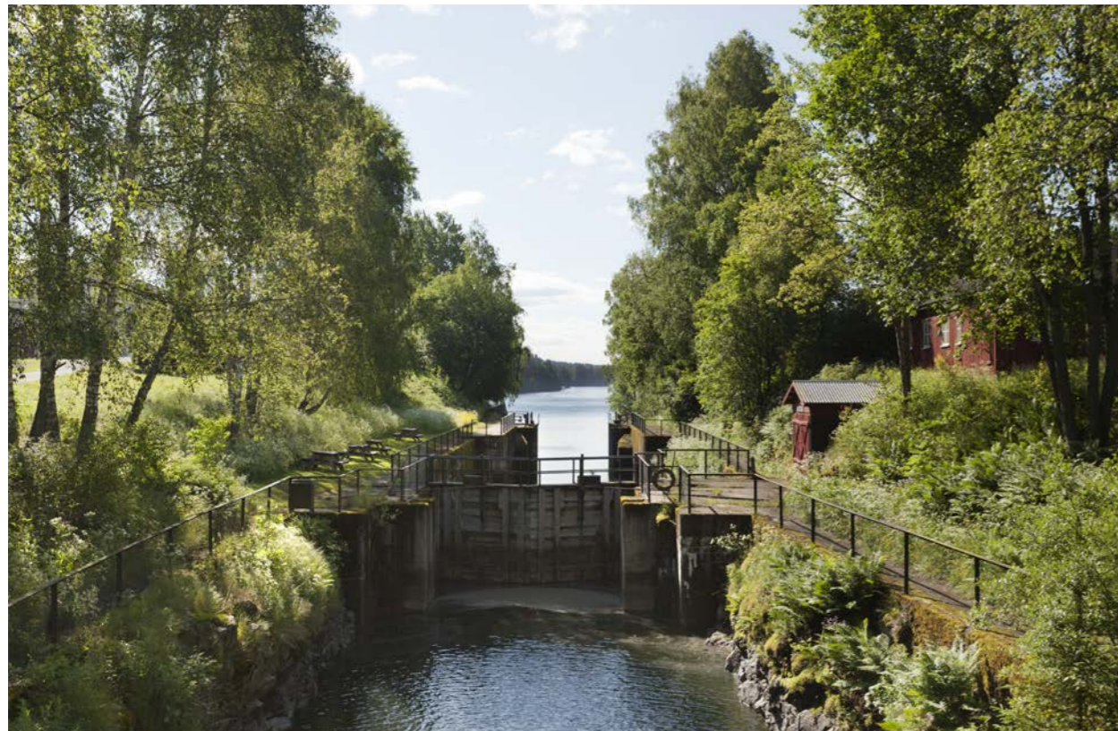
Svanfoss sluser i Vormo åpnet i 1912. Foto: Øivind Møller Bakken
