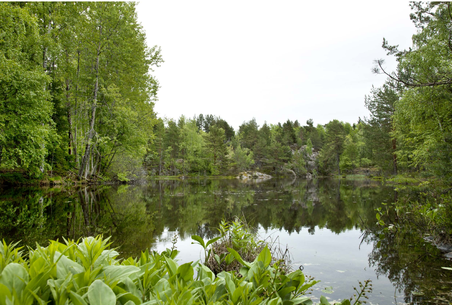
Buksedammen ved Spro, på vestsida av Sproveien, er en tidligere isdam som anlagt i perioden 1860-1890. Foto: Øivind Møller Bakken
