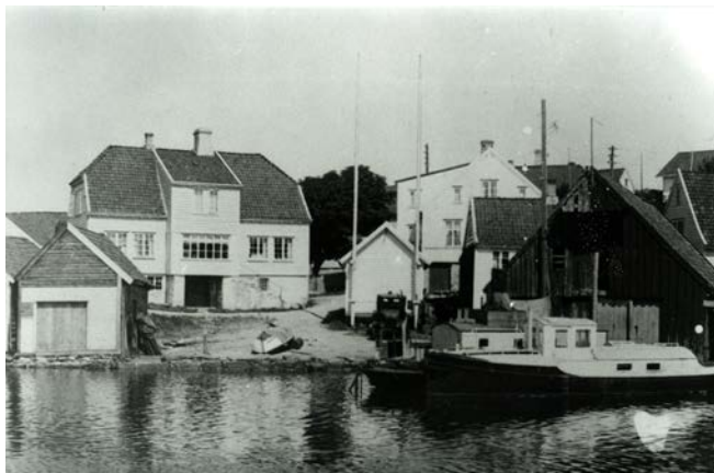
Det lille skuret midt i bildet er «sprøytehuset» fra 1880. De to stengene var i bruk til å tørke brannslanger i .
