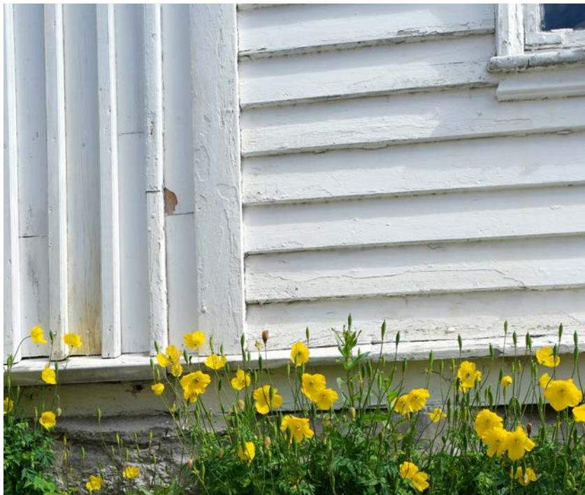
To typer panel på samme hus. Til høyre enkeltfalsset panel uten profil. Til venstre stående lektepanel.
