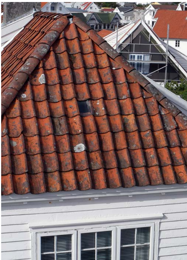
Det er ett kjent tilfelle der et tak har en takstein i glass for å slippe inn lys på loftet.
