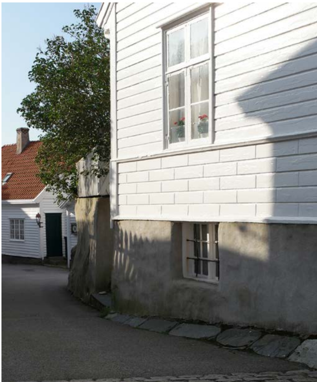
På dette empirehuset har man skapt en etterligning av mureffekt i trepanelet.
