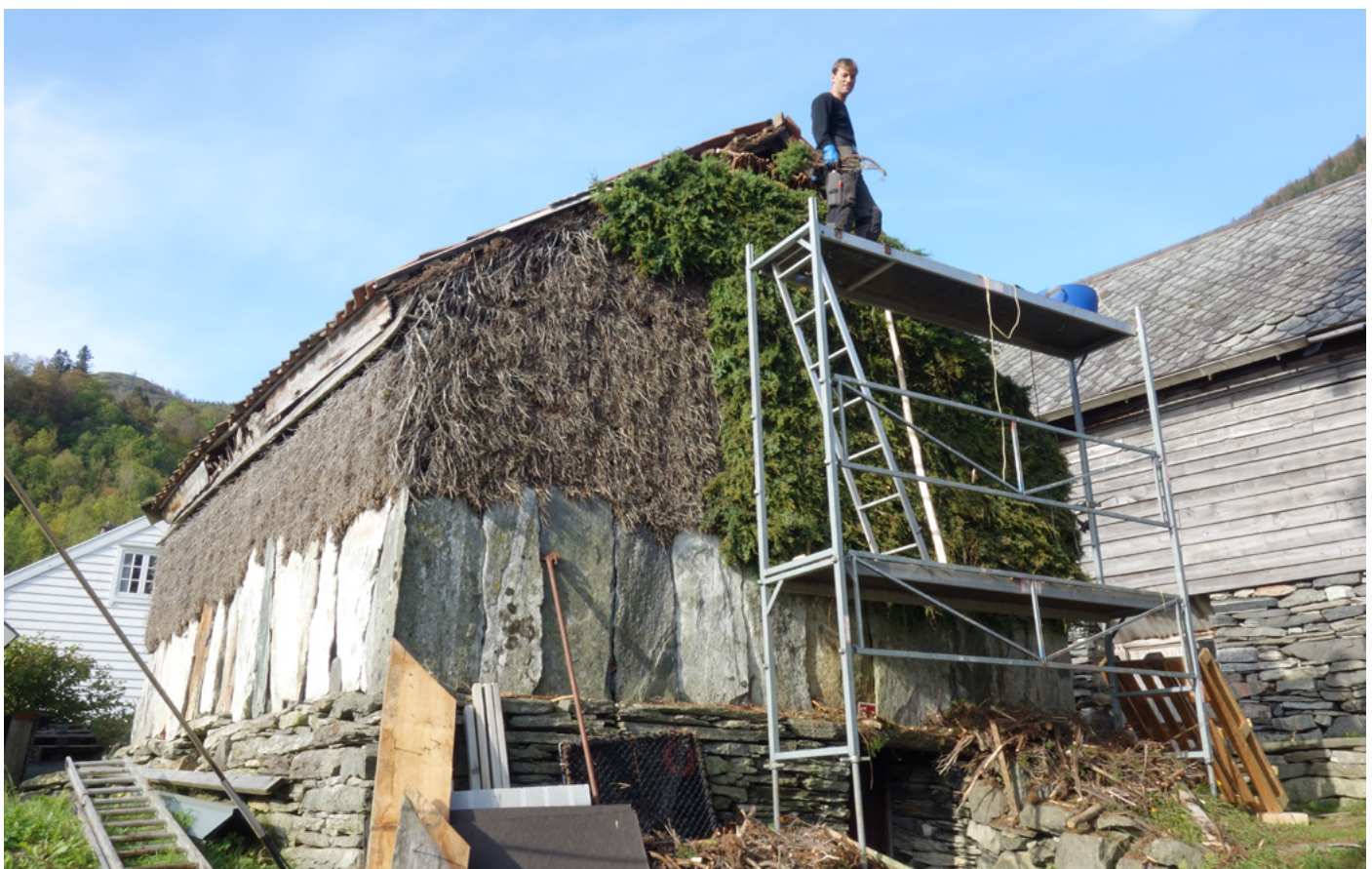
Kjetil Monstad kan kunsten å setje opp ny kledning av brake (einer). Han er leigd inn for å bøte på kledninga på Noreløa, ei av dei mange løene på Havrå. Braken som er skifta var meir enn 90 år gamal. Resten blei sett opp i 1950, og held enno. Foto: Øyvind Vatshelle
