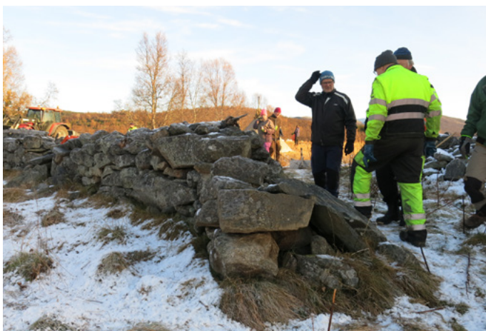
Før oppstart og under arbeid... Foto: Marit Chruickshank, Troms fylkeskommune
