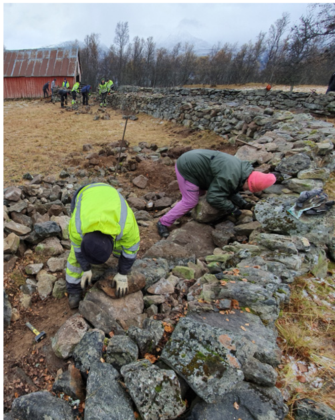
Det ble reparert omkring 60 meter steingjerde på kurset. Foto: Cathrine Amundsen, Fylkesmannen i Troms og Finnmark
