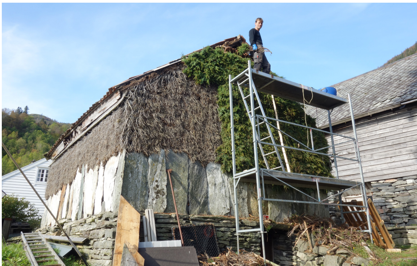
Kjetil Monstad kan kunsten å setje opp ny kledning av brake (einer). Han er leigd inn for å bøte på kledninga på Noreløa, ei av dei mange løene på Havrå. Braken som er skifta var meir enn 90 år gamal. Resten blei sett opp i 1950, og held enno. Foto: Øyvind Vatshelle
