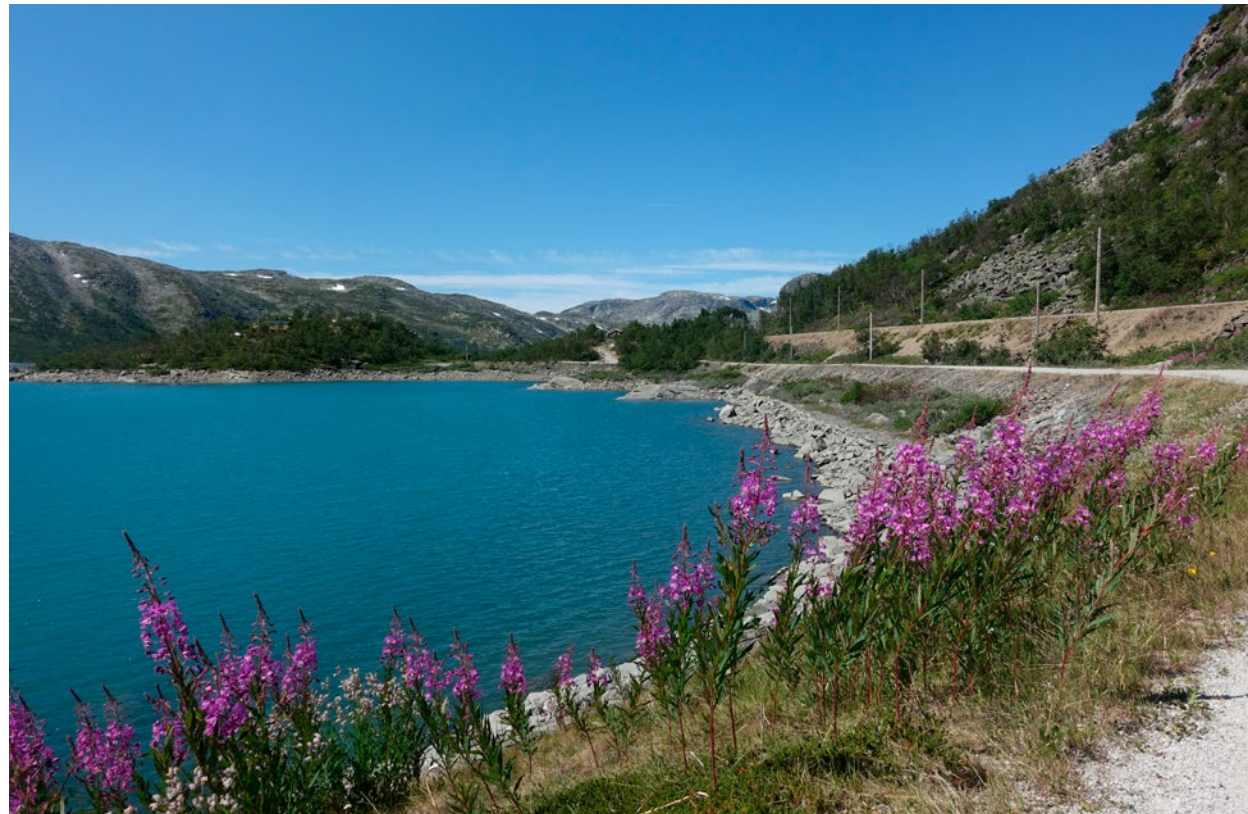
Langs Nygardsvatnet rett vest for Haugastøl ligger Rallarvegen og Bergensbanen tett inntil hverandre. Foto: Jørn Jensen, Buskerud fylkeskommune
