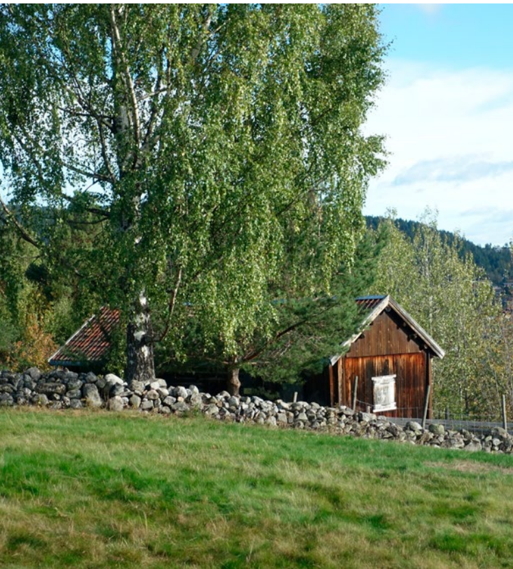
På Bergeløkka står en av de svært få gjenværende løkkelåvene på sin opprinnelige plass, og med alle funksjoner bevart: oppholdsrom, høyla, redskapsrom og do. Foto: Jørn Jensen, Buskerud fylkeskommune
