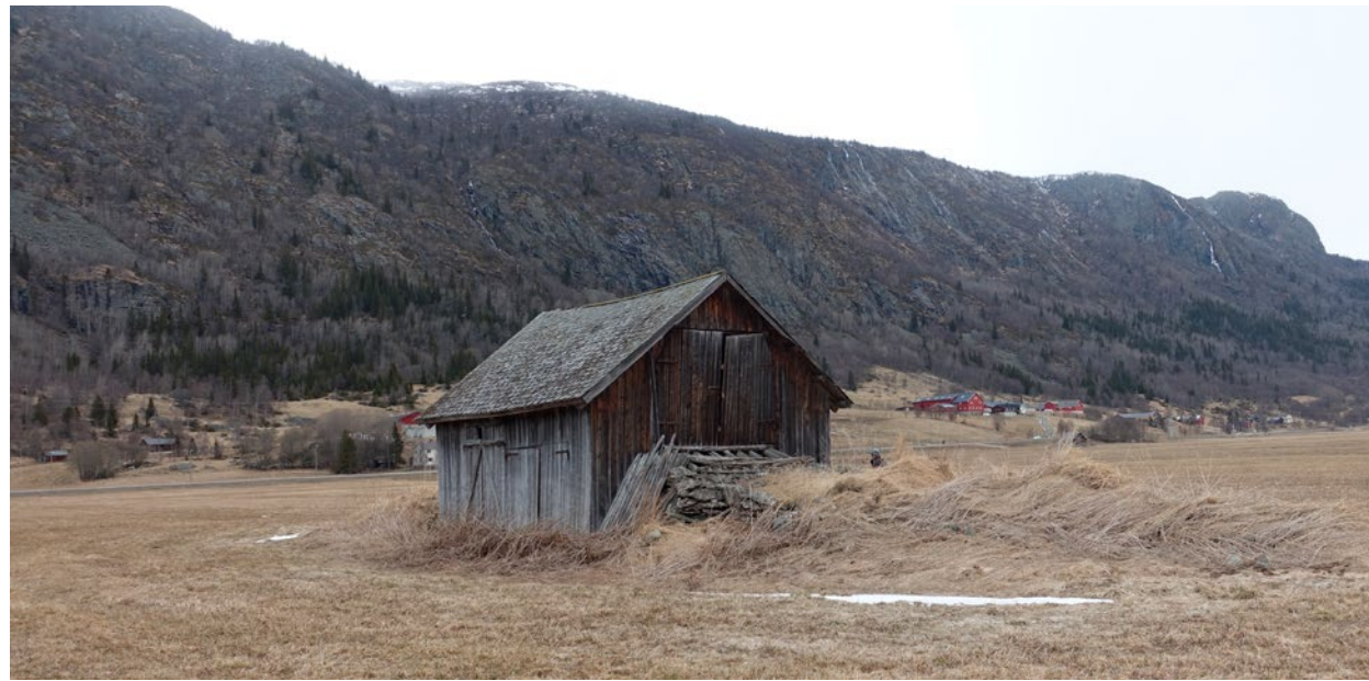
En av de mange løene på Joleimsmyran. I bakgrunnen skimtes noen av gårdstuna innenfor landskapet. Foto: Jørn Jensen, Buskerud fylkeskommune
