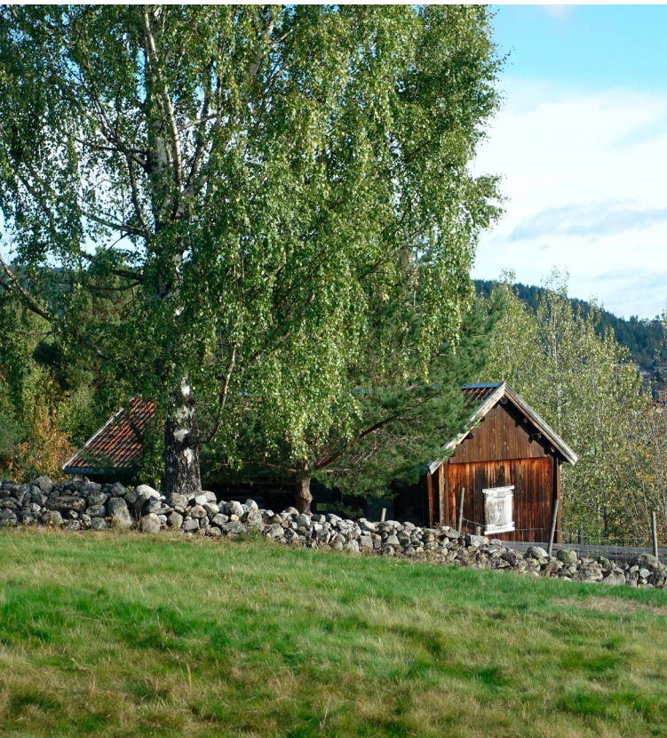
På Bergelokka står en av de svært få gjenværende løkkelåvene på sin opprinnelige plass, og med alle funksjoner bevart: oppholdsrom, høyla, redskapsrom og do. Foto: Jørn Jensen, Buskerud fylkeskommune
