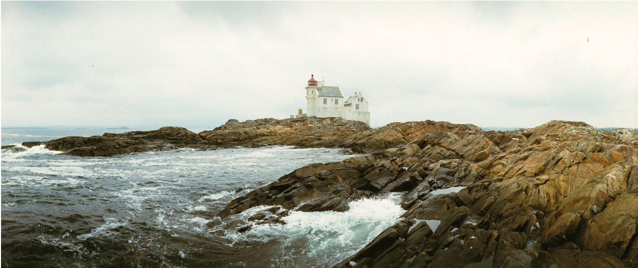
Grønningen fyr ytterst i Kristiansandsfjorden. Foto: Arve Kjerseim, Riksantikvaren
