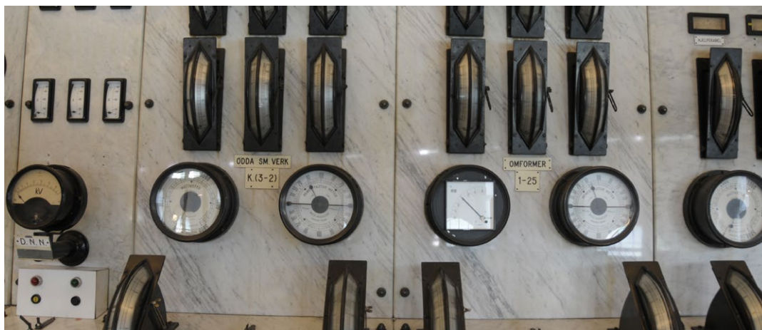
Foto: Marit Bendz, Riksantikvaren
