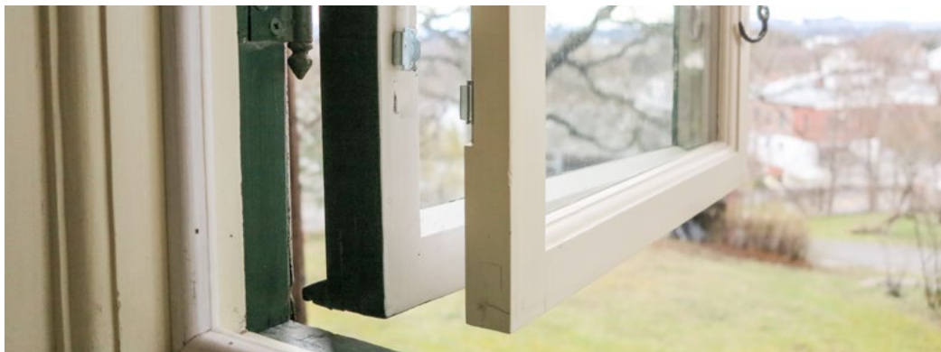
Smart oppgradering: Originalvindu med nytt varevindu koblet til det gamle.
